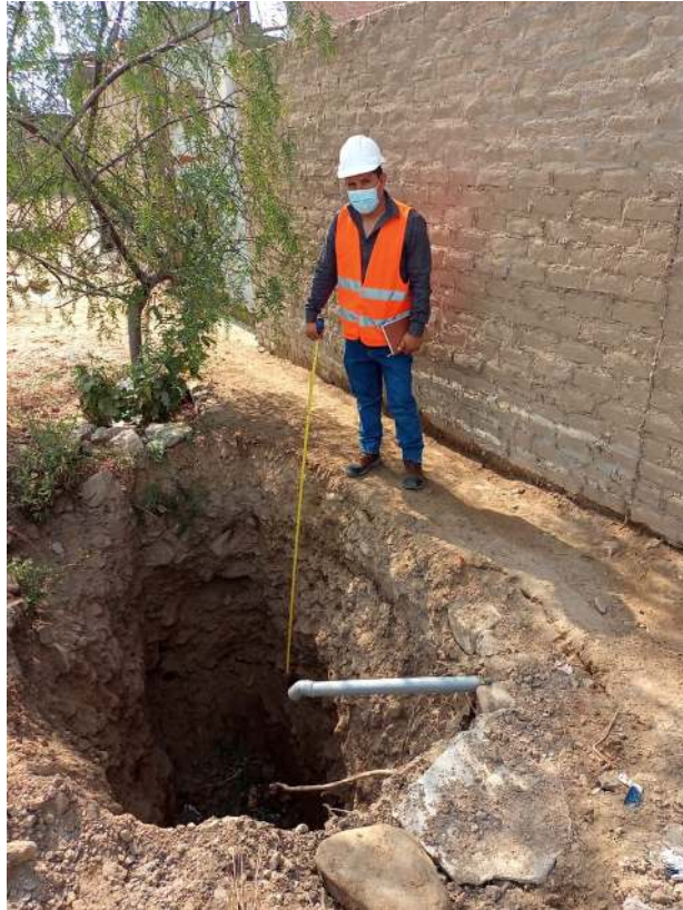
Figura 2. Utilización de pozo ciego para evacuación de desagüe de vivienda en el Sector Los Claveles
