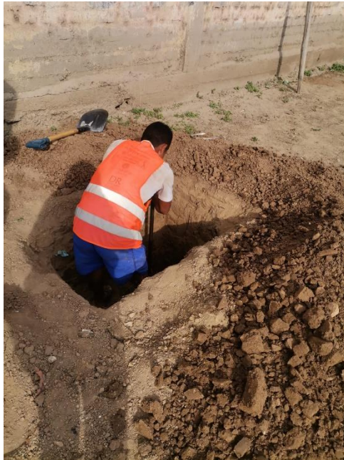
Figura N° 23: Excavación de calicata 1
