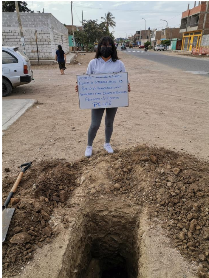
Figura N° 24: Excavación de calicata 2
