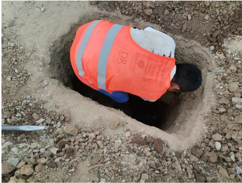
Figura N° 24: Excavación de calicata 2
