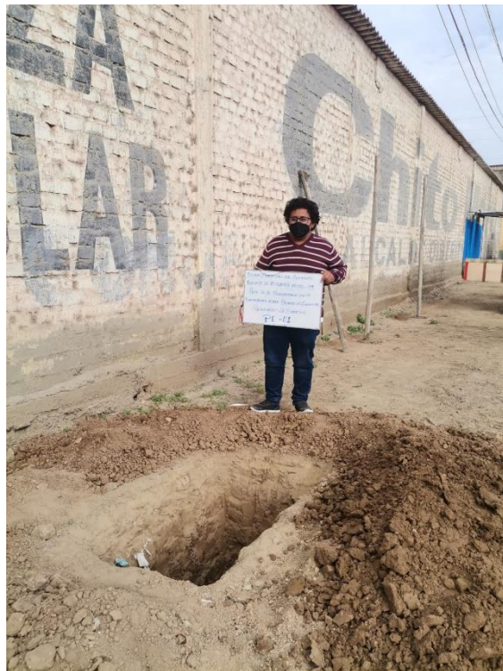
Figura N° 23: Excavación de calicata 1
