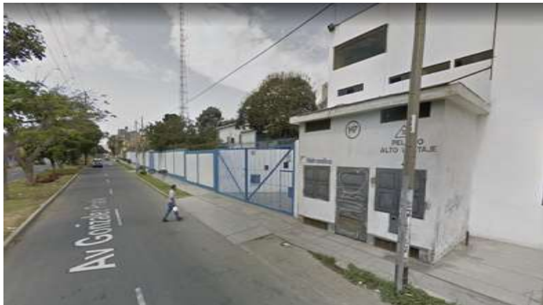
Figura 114. Estación de Hidrandina.
