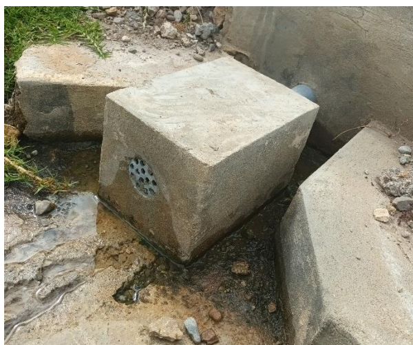
Imagen 04: Tubería de rebose
