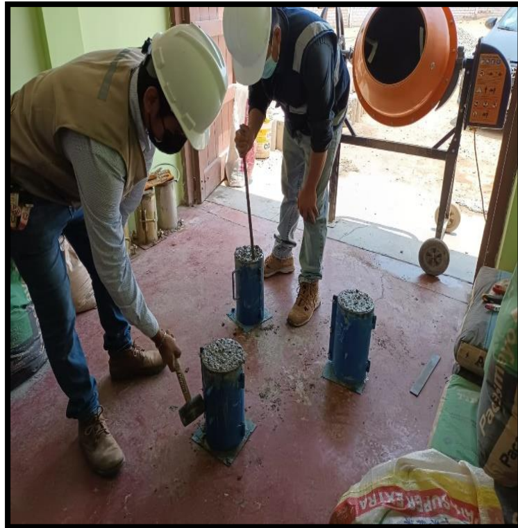
Figura 37: Preparación de concreto en moldes
