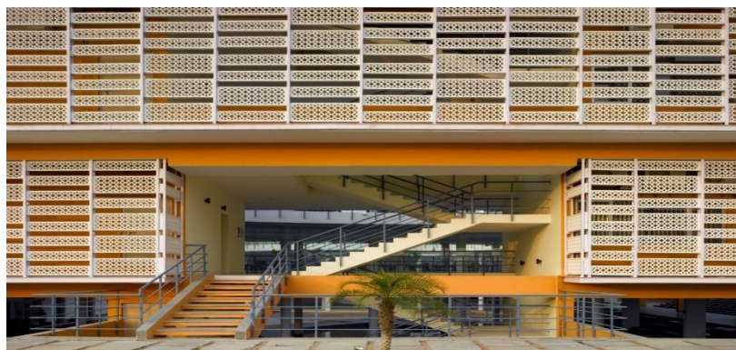
Imagen 29: Circulación interior. Fuente: Archdaily
