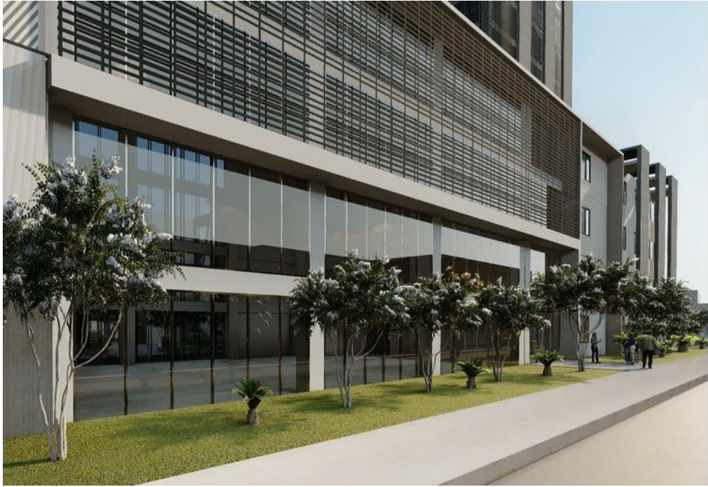
Imagen 123: Vista de muro cortina en CITE. Fuente: elaboración propia
