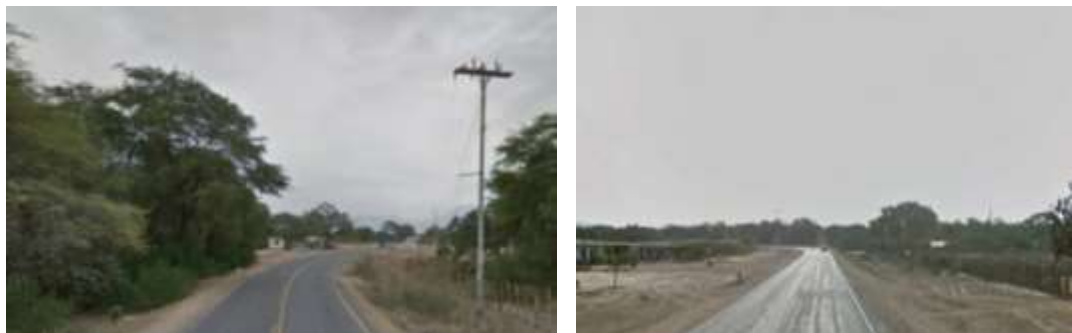
Figura 5. Vía de acceso asfaltada carretera Pítipu y la vía 103 en dirección al ingreso principal al SHBP. Fuente: Grupo de Tesis
