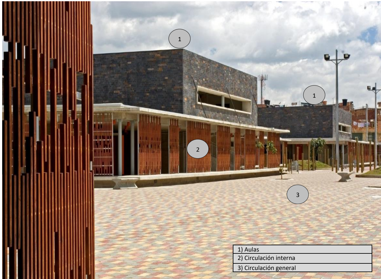
Imagen 17: Vista Aulas y Fachadas de la Institución Educativa Gerardo Molina
