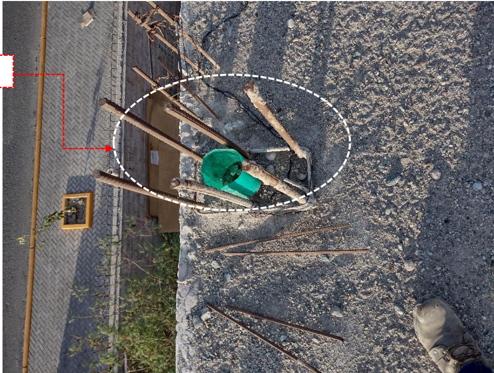
Figura 29. Arranque de acero exterior en columna de pórtico Bloque 2 Fuente: Propia
