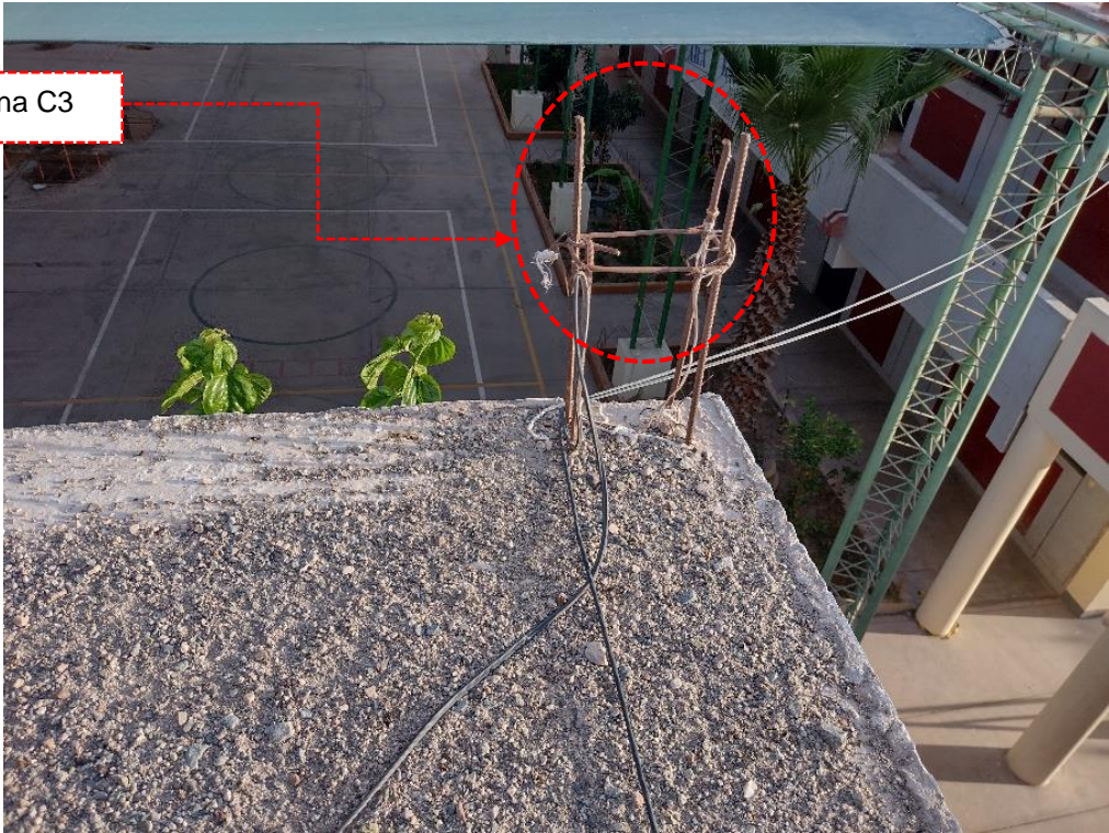
Figura 27. Arranque de acero en columna de confinamiento Bloque 2 Fuente: Propia
