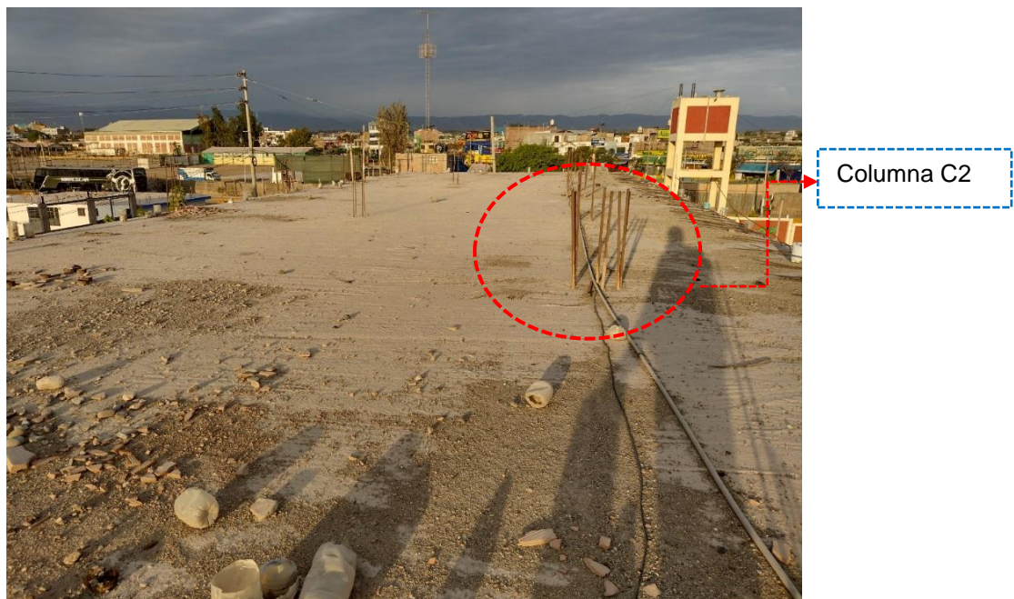
Figura 17. Arranque de acero interior en columna de pórtico Bloque 1 Fuente: Propia
