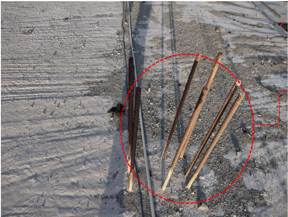
Figura 28. Arranque de acero interior en columna de pórtico Bloque 2 Fuente: Propia
