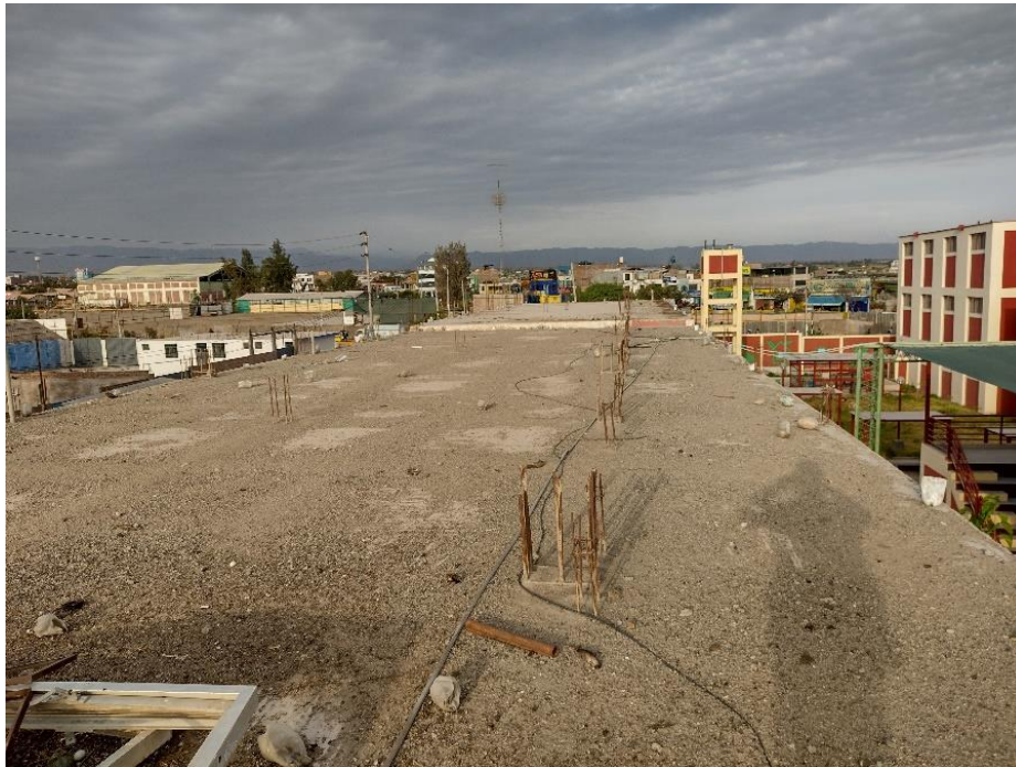
Figura 26. Arranques de columnas existentes Bloque 2 Fuente: Propia
