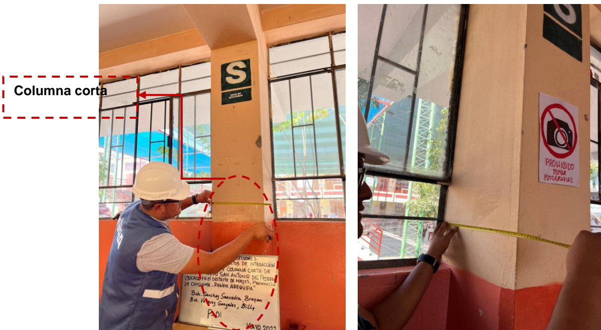
Figura 73 Columna corta en bloque 1 (vista interior) Fuente: Propia
