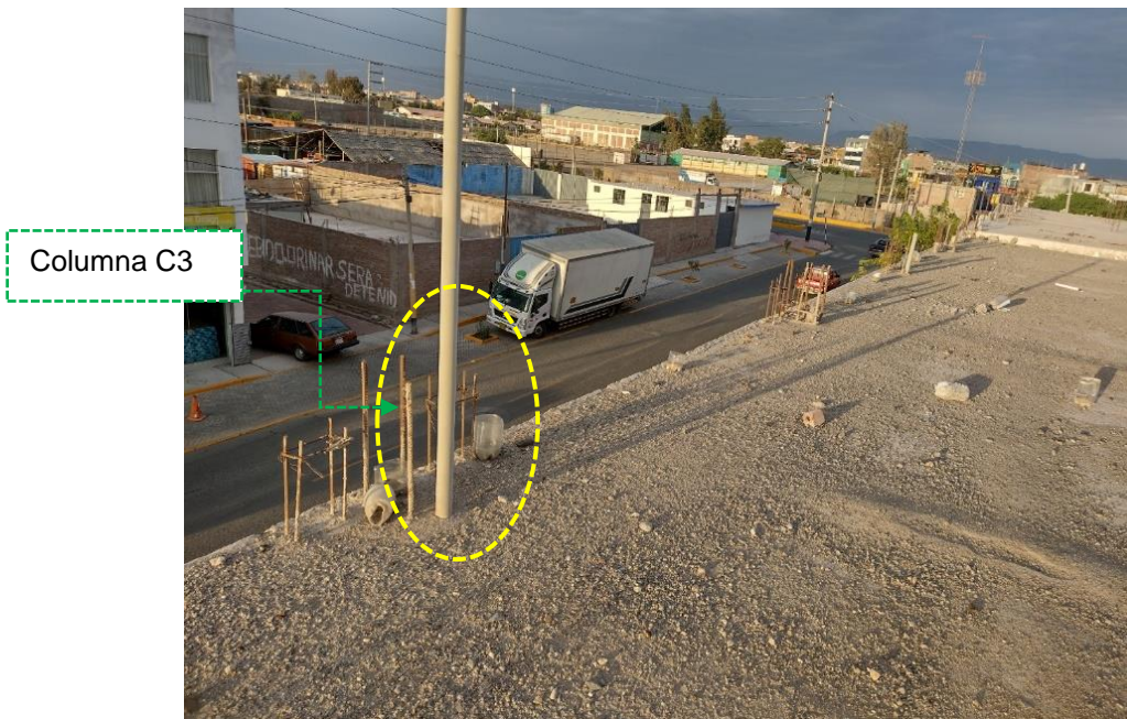
Figura 16. Arranque de acero en columna de confinamiento Bloque 1 Fuente: Propia
