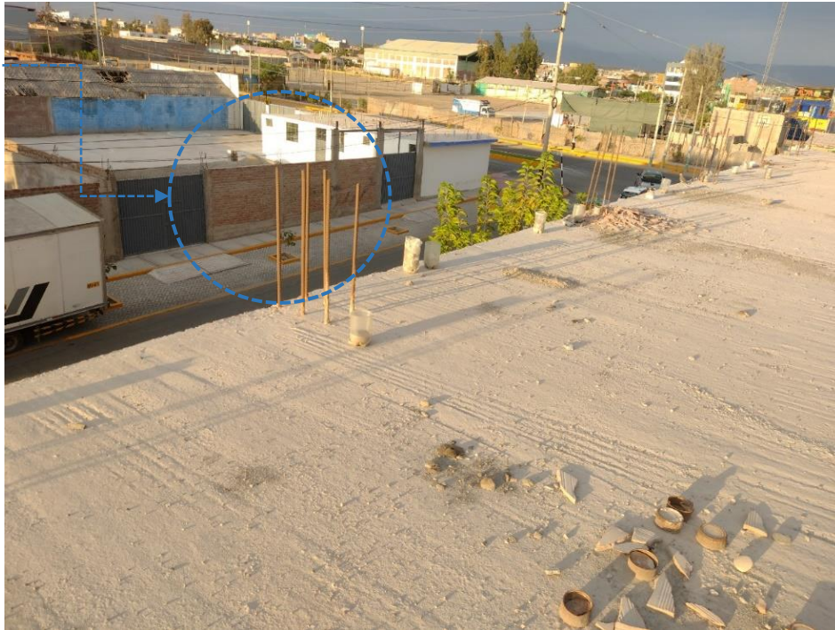
Figura 18. Arranque de acero exterior en columna de pórtico Bloque 1 Fuente: Propia
