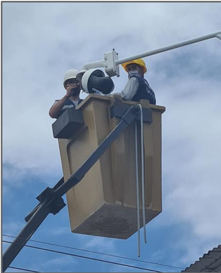
Instalación de Cámara PTZ
