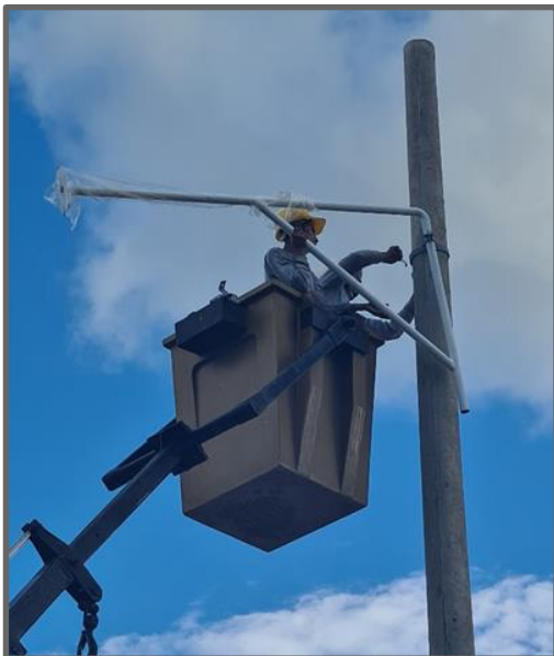
Instalación del Brazo Metálico
