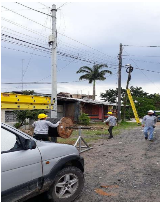
Tendido de Fibra Óptica
