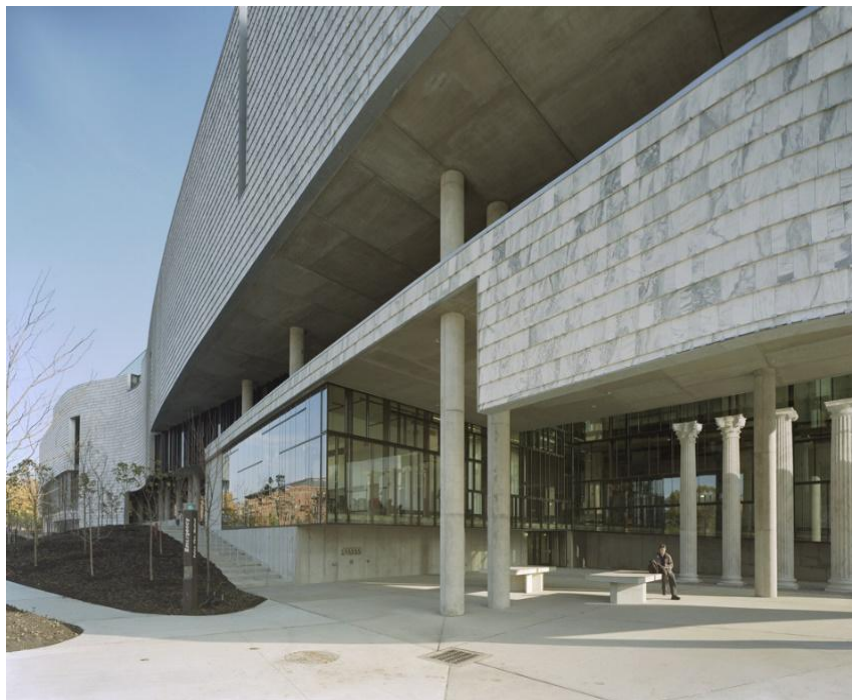
Figura 2: Fotografía del ingreso principal
