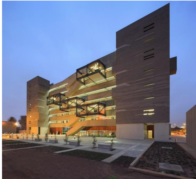
Figura 9: Fachada principal del aula
