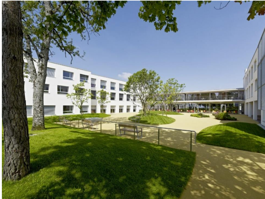
Ilustración 6. Patio principal (Residencial Paix du sour)
