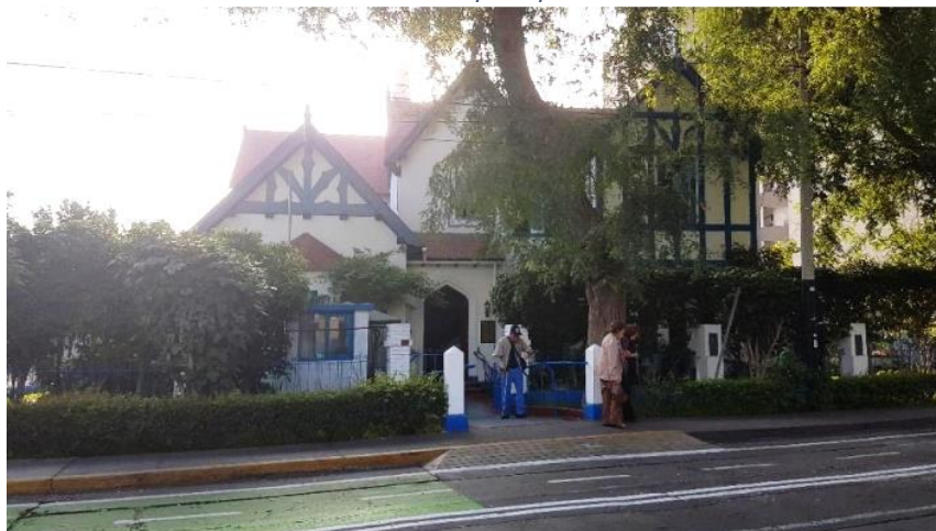
Ilustración 17. Vista de la fachada principal del cam San Isidro.
