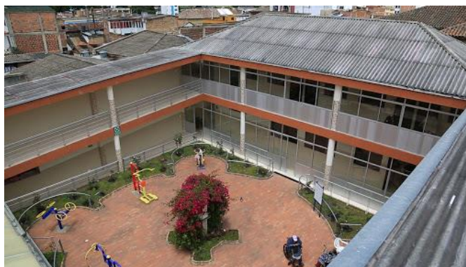
Ilustración 76. Patio principal central - Asilo San José
