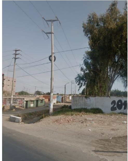
FOTOGRAFIA N° 32: Línea de alta tensión que pasa por la carretera panamericana Fuente: Trabajo de campo
