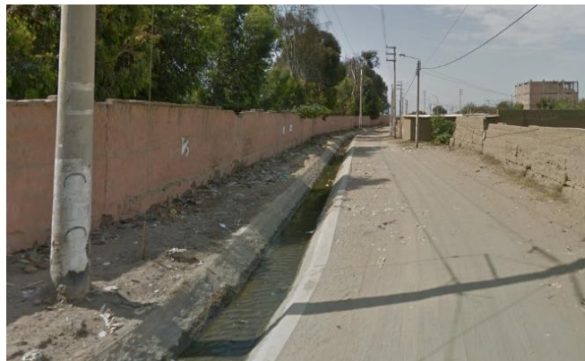
FOTOGRAFIA N° 31: Canal de regadío que pasa por una de los accesos al terreno Fuente: Trabajo de campo
