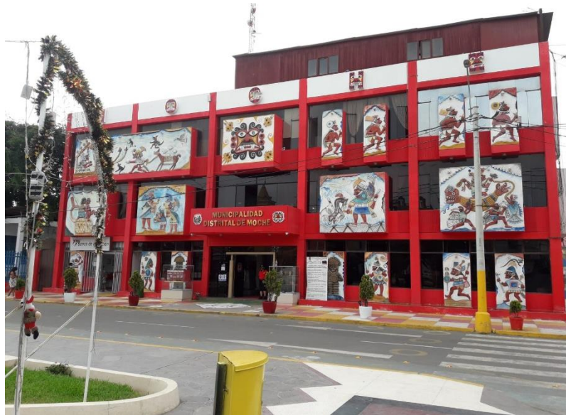
FOTOGRAFIA N° 25: Municipalidad distrital de Moche
