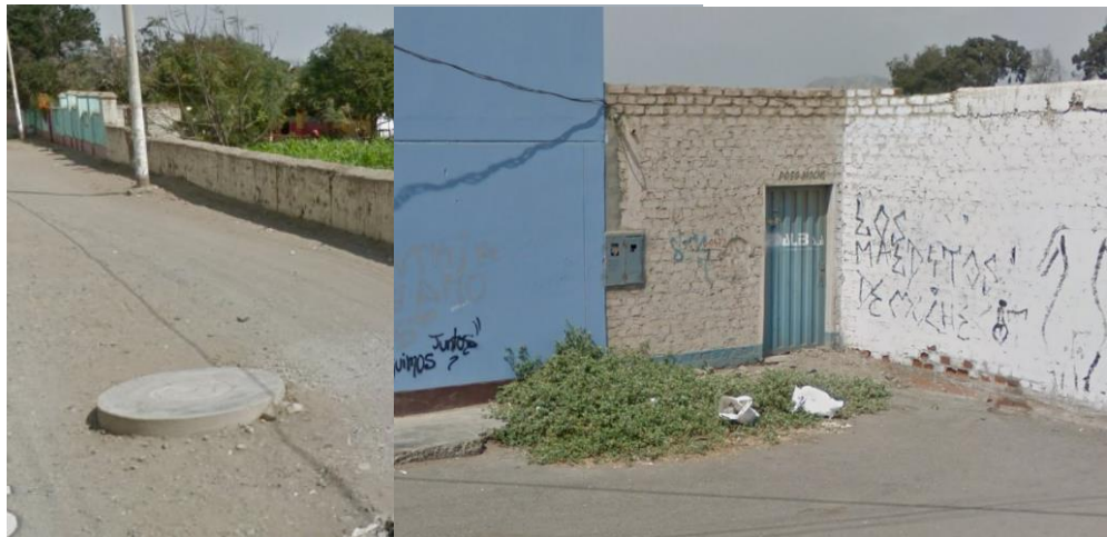
FOTOGRAFIA N° 30: Caseta de bombeo de SEDALIB, ubicada cerca al terreno Fuente: Trabajo de campo
