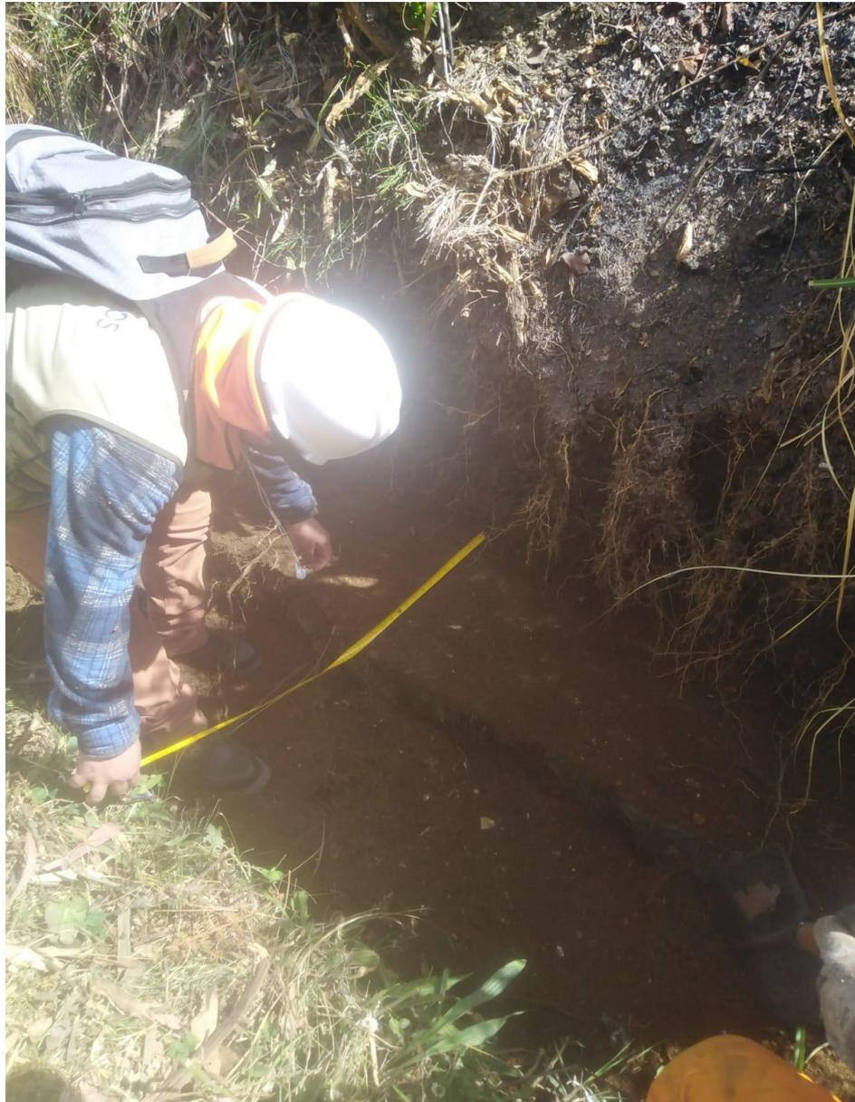
*Nota:* Esta figura muestra la verificación de metrados en la excavación del canal, por Castañeda y Chavarry 2023
