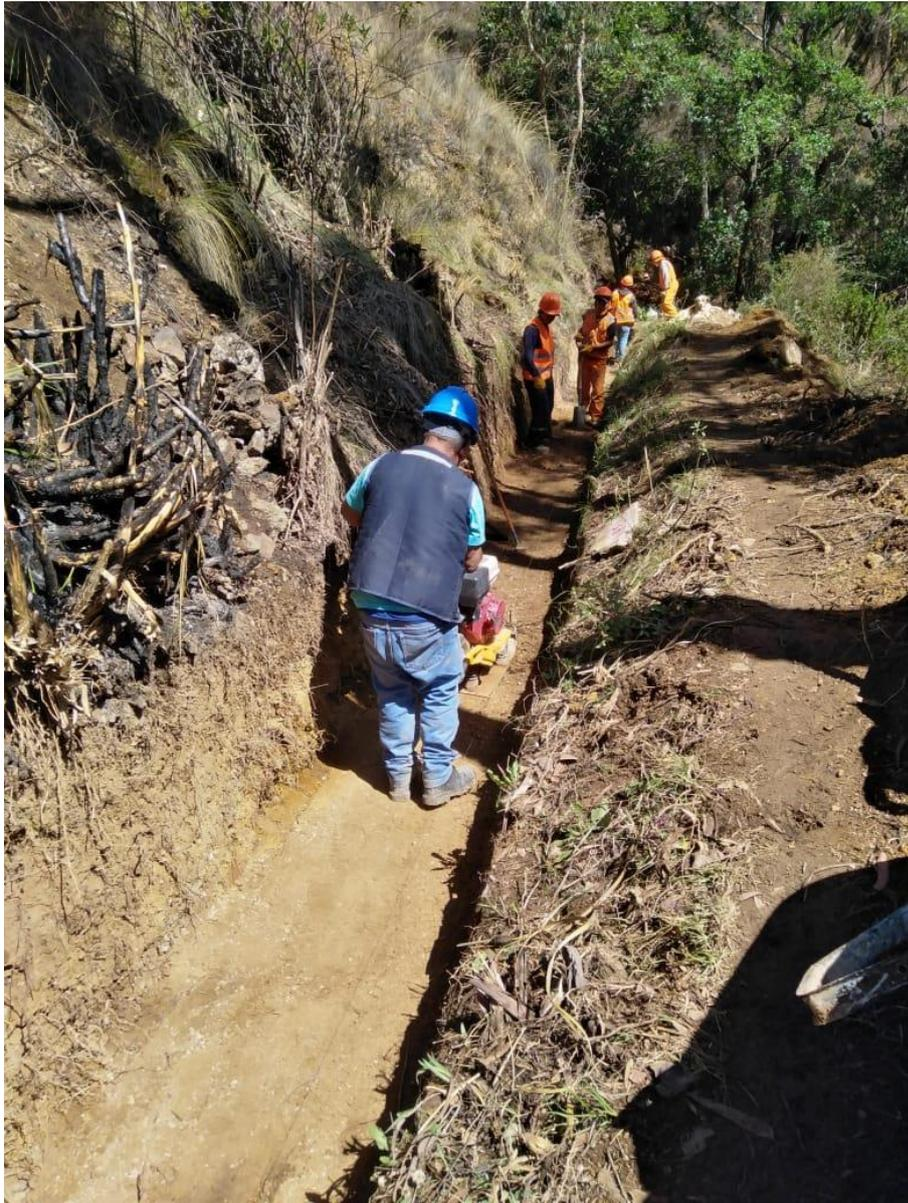
*Nota:* Esta figura muestra la verificación de los trabajos de perfilamiento y compactación de canal, por Castañeda y Chavarry 2023
