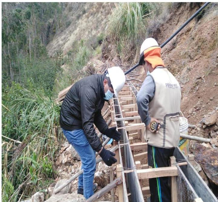
*Nota:* Esta figura muestra la verificación de los trabajos de encofrado normal y caravista de canal, por Castañeda y Chavarry 2023
