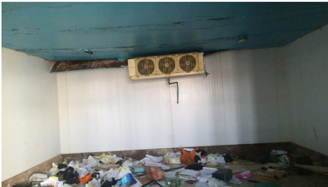
Imagen 9: Zona de frigorífico, estado actual 2022
