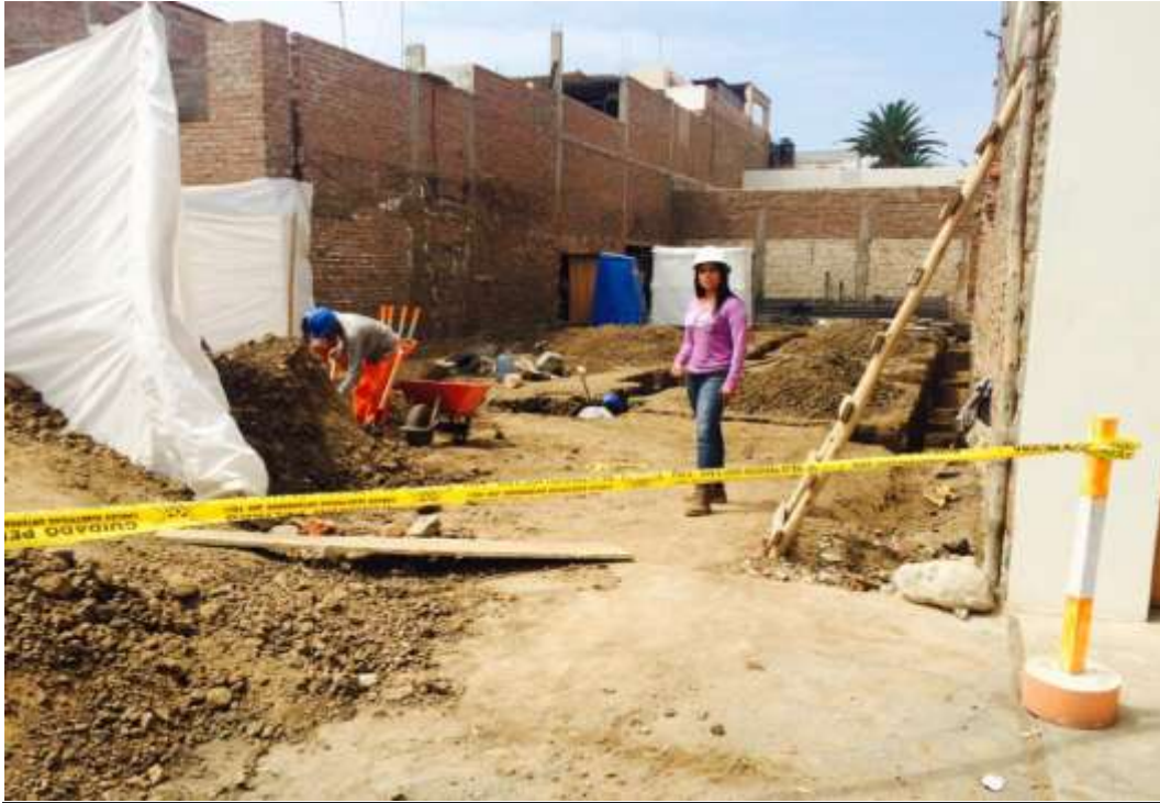
Observación directa de la Obra "Residencial Mostacero" por Brenda García Coronado.
