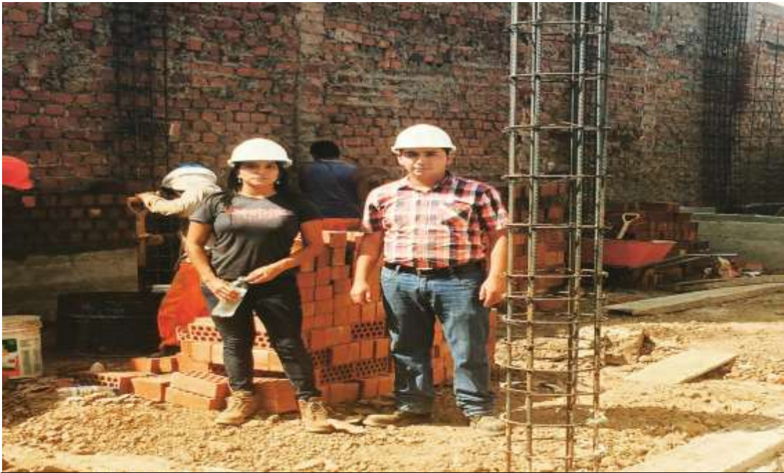
Ambos tesistas Brenda García Coronado y Erickson Ruíz Fernández observando el avance de obra "Residencial Mostacero" turno tarde.
