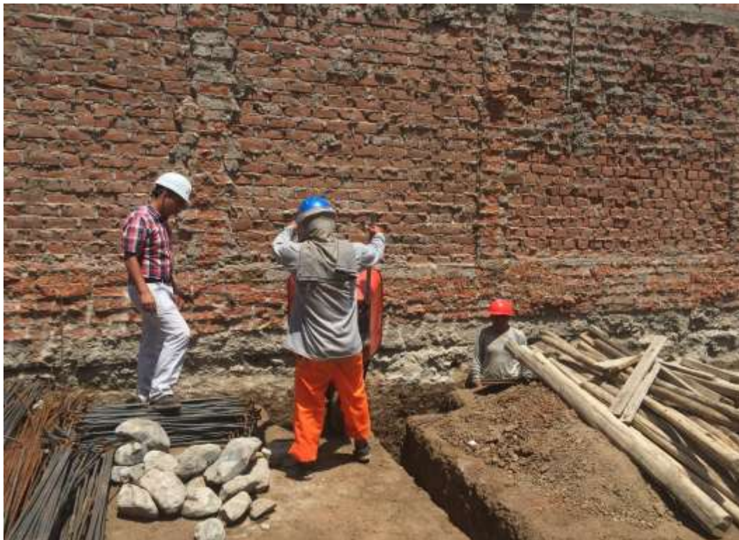
Observación directa de la Obra "Residencial Mostacero" por Erickson Ruiz Fernandez
