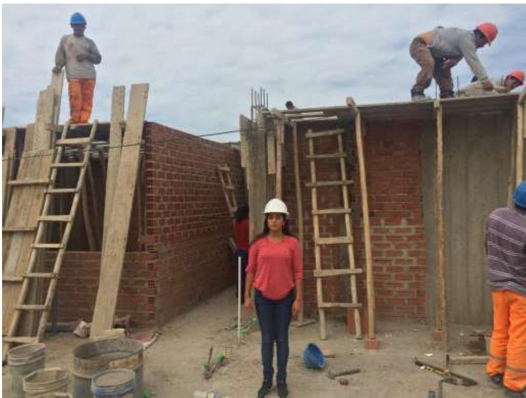
Brenda García Coronado registrando el avance en obra ( Muros del tercer piso)
