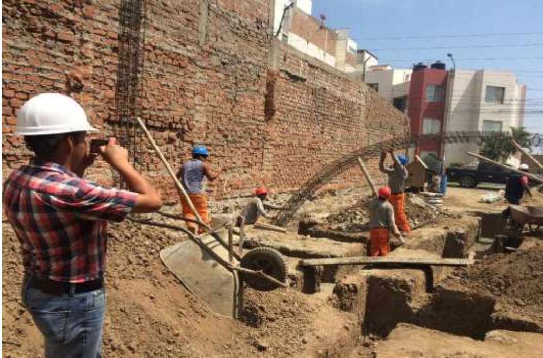
Erickson Ruíz fotografiando evidencias del avance de obra (Acero de columnas)
