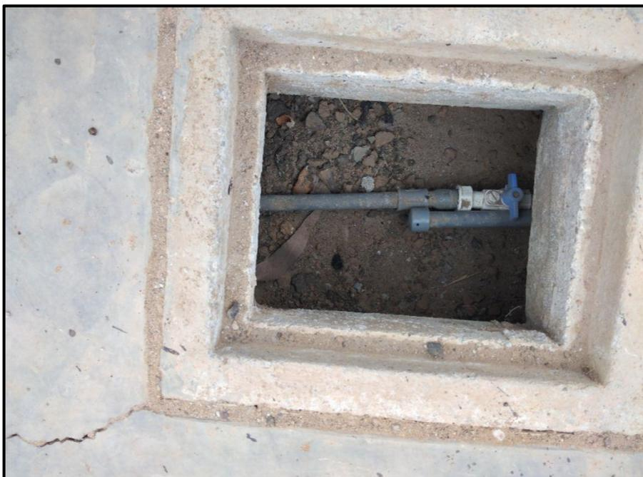
Conexión domiciliar conectada a la vivienda con presencia de fisuras en vereda y cajas de concreto.
