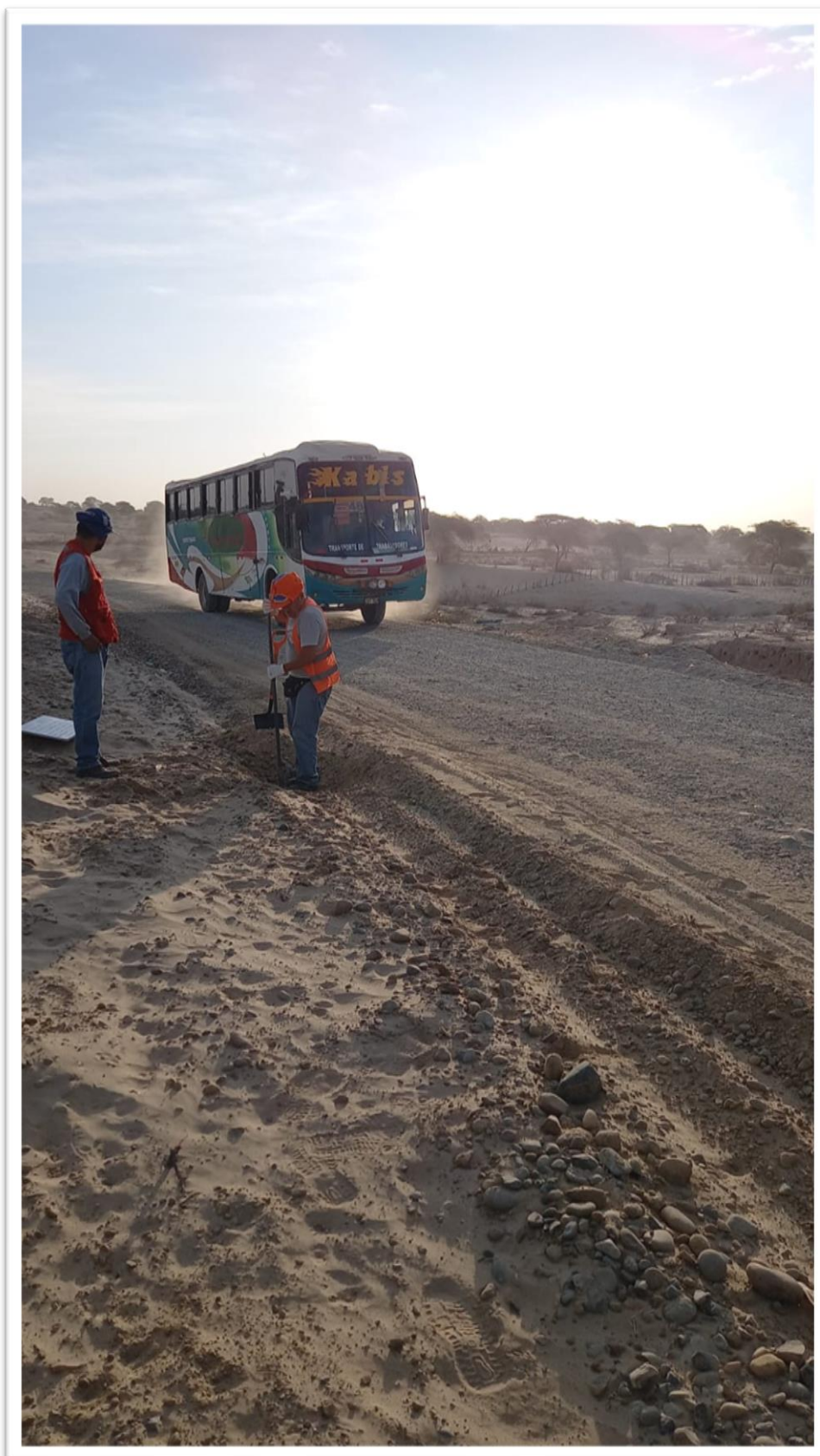
Foto 16: Calicata 3 lado izquierdo de la vía con profundidad de 1.50m.
