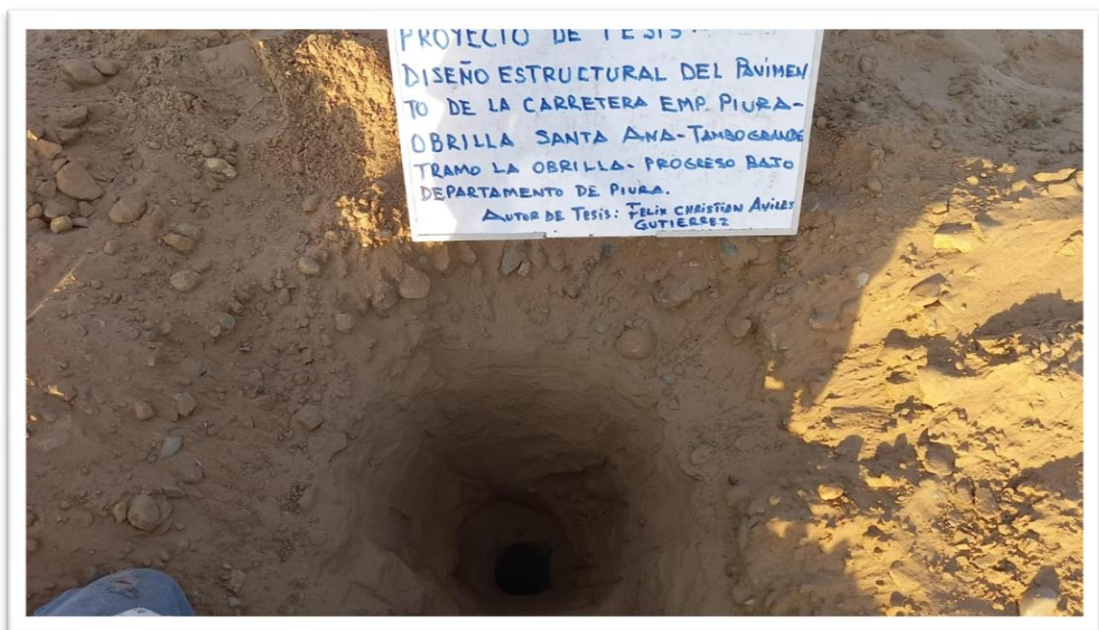
Foto 12: Se muestra el suelo perforado se evidencia la estratigrafía del suelo pasando el nivel de sub rasante altura de 1.50 m..
