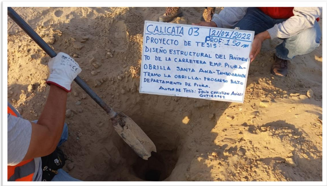
Foto 13: Se excavaron tres calicatas al costado de la vía para no interrumpir el tráfico se identificaron y describieron las características de los materiales según su estratigrafía.
