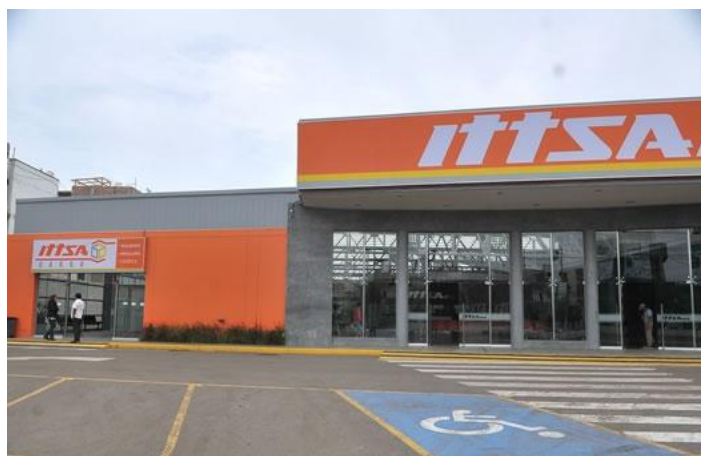
OFICINA TRUJILLO - SALIDA AL SUR
