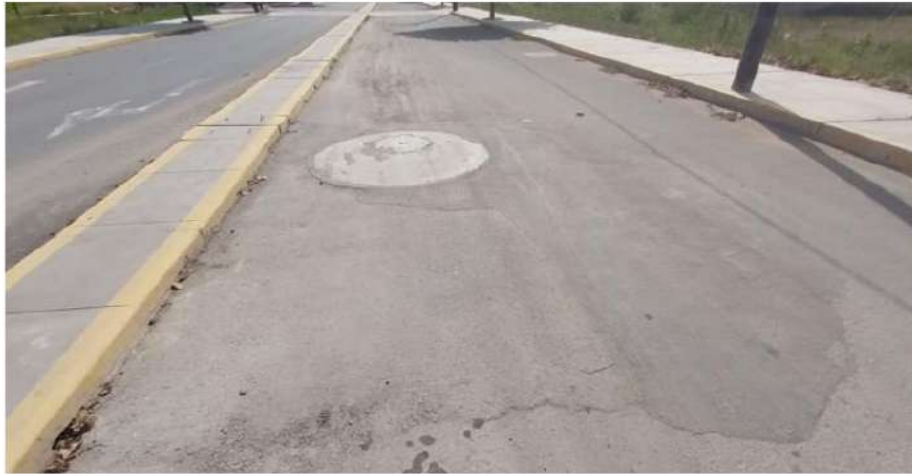
Figura 28. Parchado por hundimiento de la zona, progresiva 0+560.
