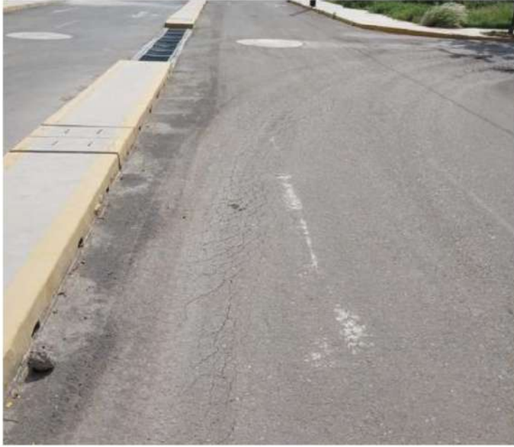
Figura 22. Inicio de fisuración por fatiga de la estructura en la progresiva 0+368.
