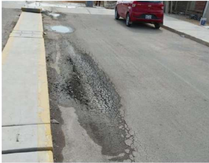
Figura 22. Inicio de fisuración por fatiga de la estructura en la progresiva 0+368.
