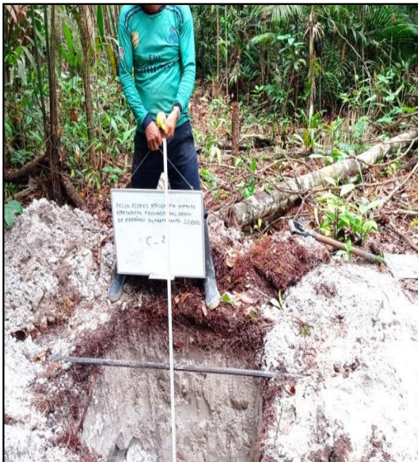
Profundidad de excavación de 1.50m
