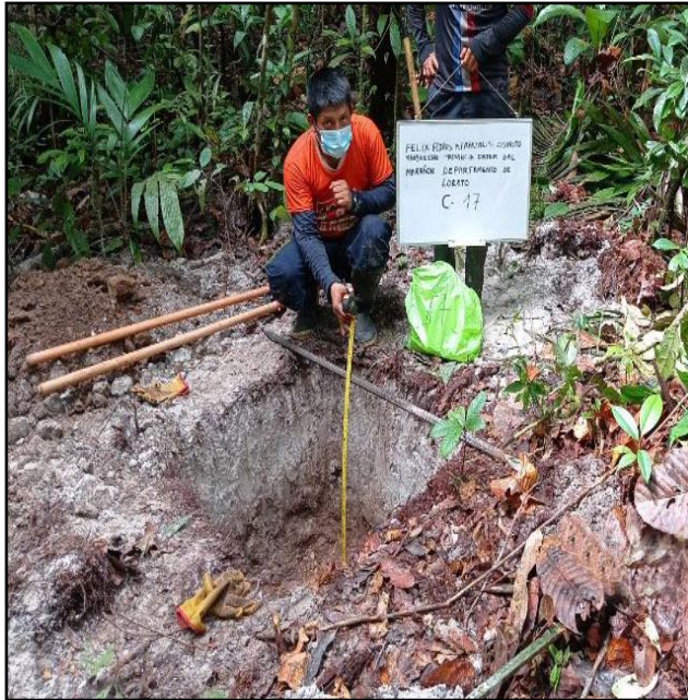
Profundidad de excavación de 1.50m
