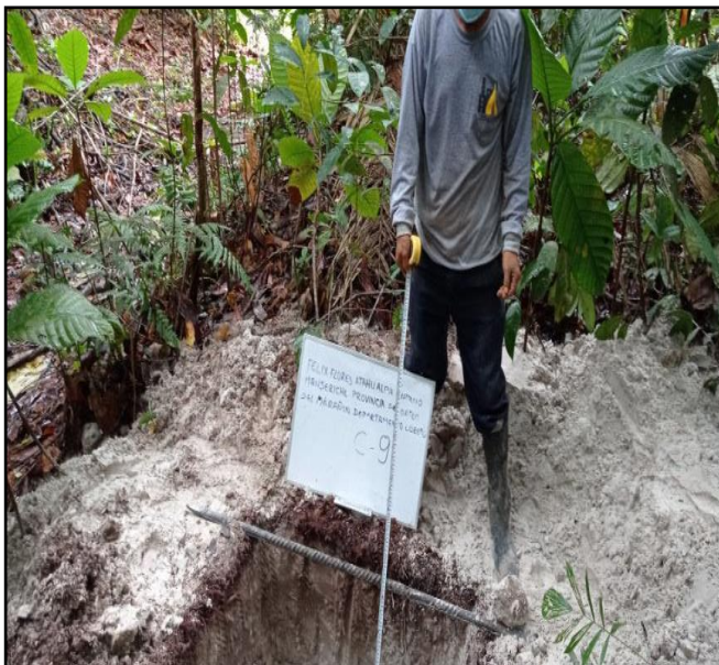
Profundidad de excavación de 1.50m
