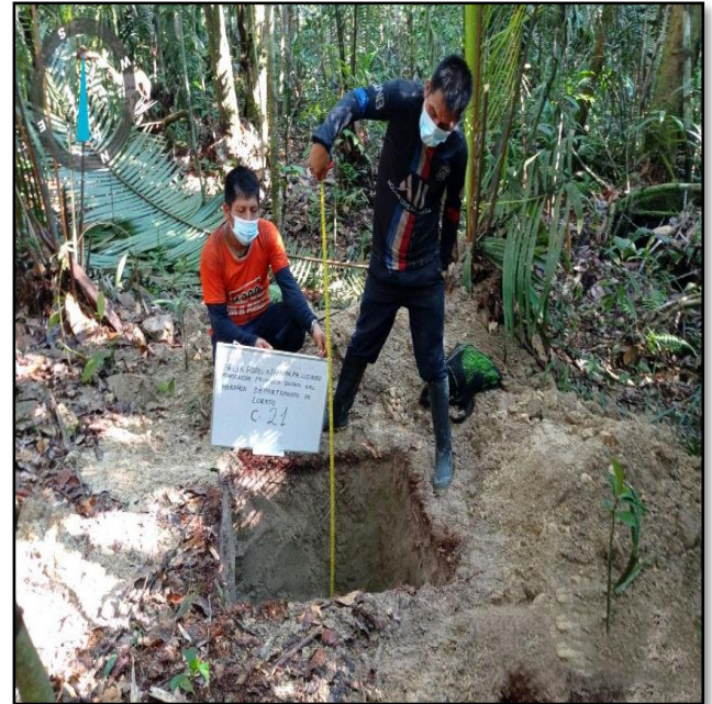
Profundidad de excavación de 1.50m
