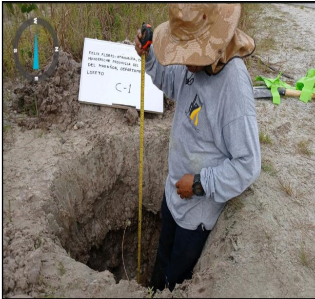
Excavación de Forma Manual.
