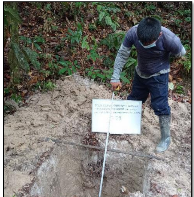
Profundidad de excavación de 1.50m
