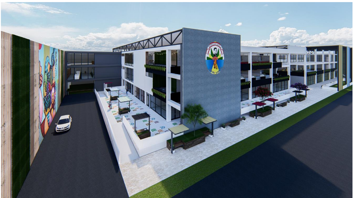
FIGURA N° 78. Vista de fachadas secundaria.
