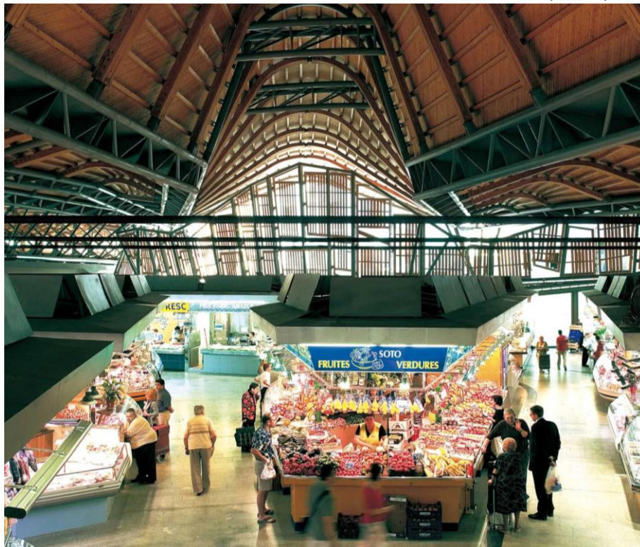
FIGURA Nº 14. Interior Mercado Santa Caterina (2004).
