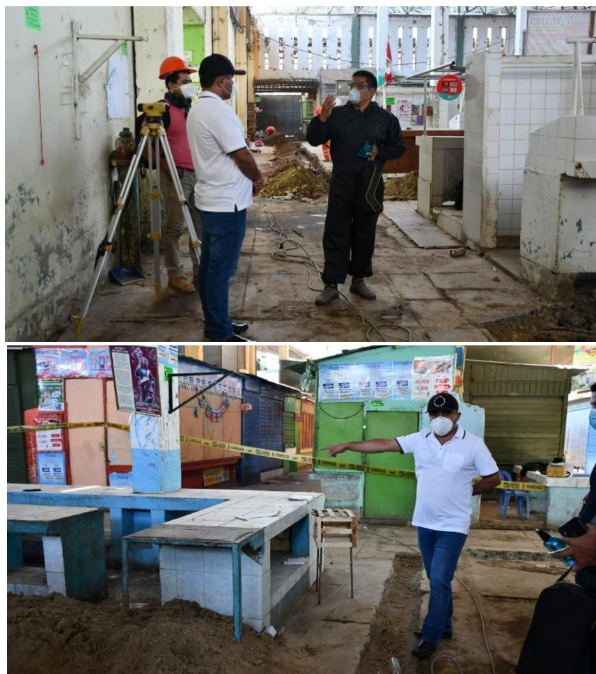
FIGURA Nº 22. Remodelación del Mercado Central.
