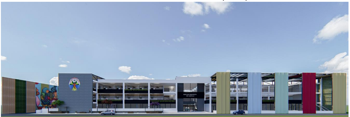
FIGURA N° 77. Vista de fachadas principal.
