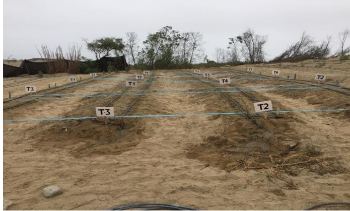
Anexo 3. Instalación de sistema de riego y carteles
