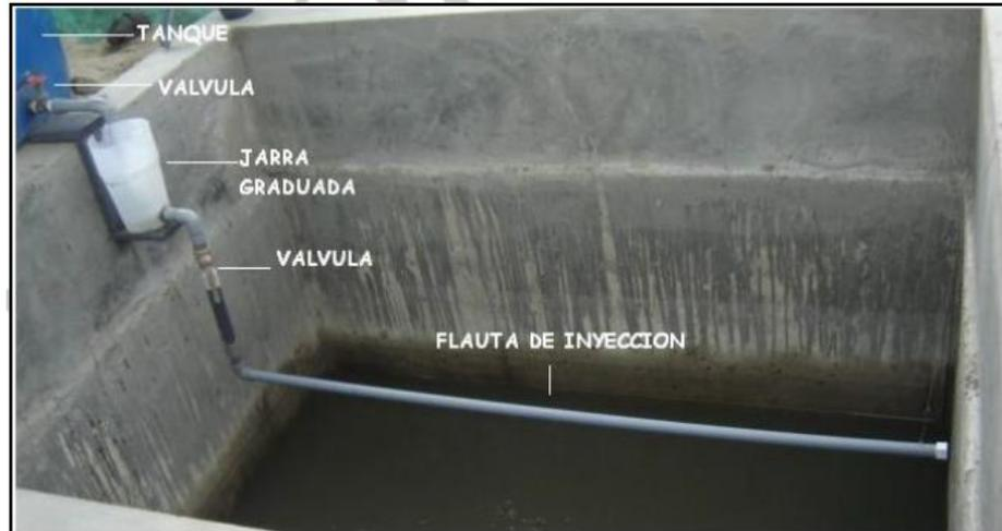
Figura N° 41: Elementos para la dosificación e inyección
