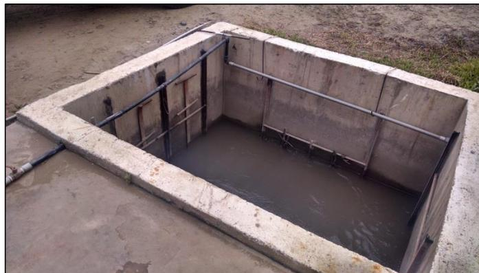
Figura N° 33: Cámara de Dosificación 1
