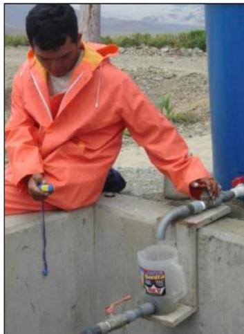
Figura N° 40: Regulación de dosis mediante jarra graduada
