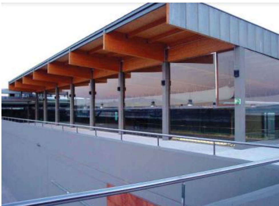
FIGURA Nº 57 Cubierta formada por vigas de canto uniforme
