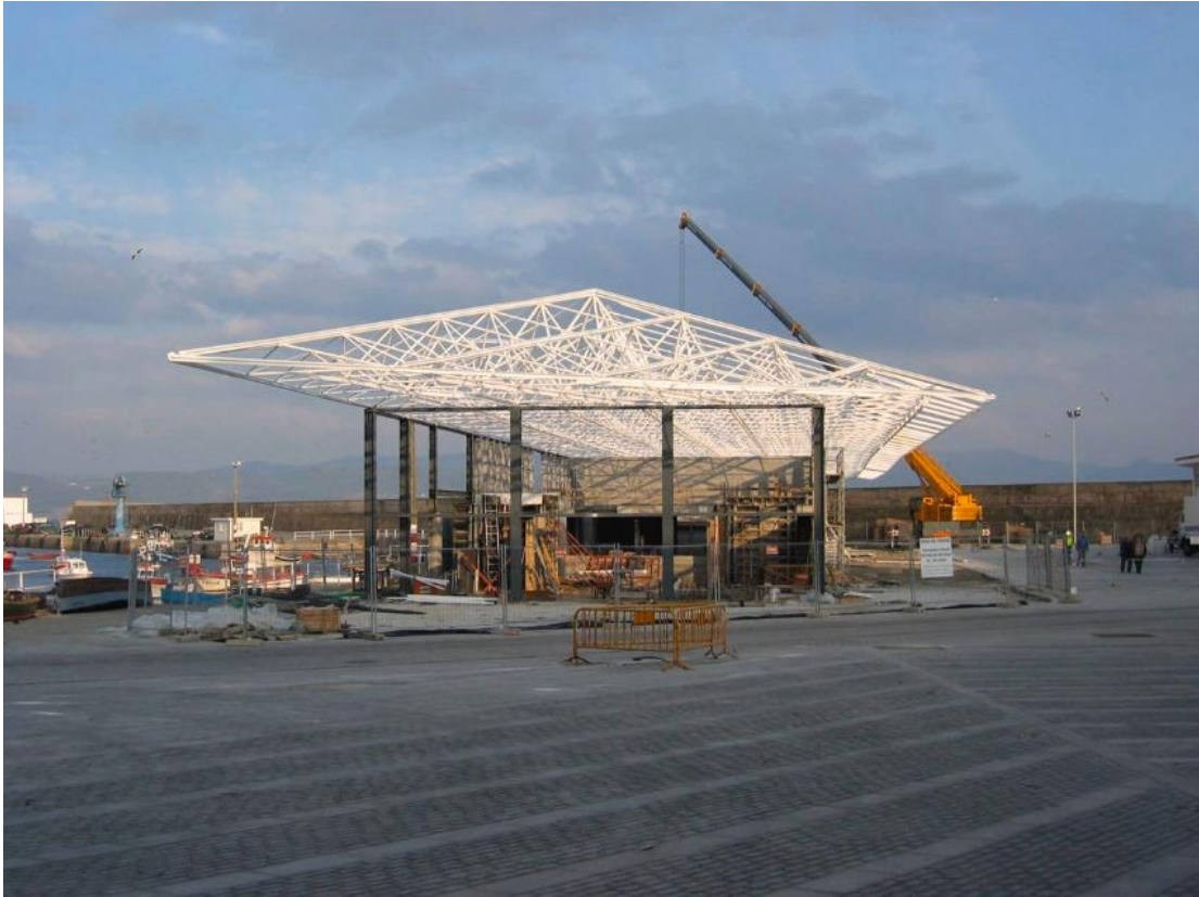
FIGURA N° 67 Estructura de cubierta (Lonja de Fisterra)
