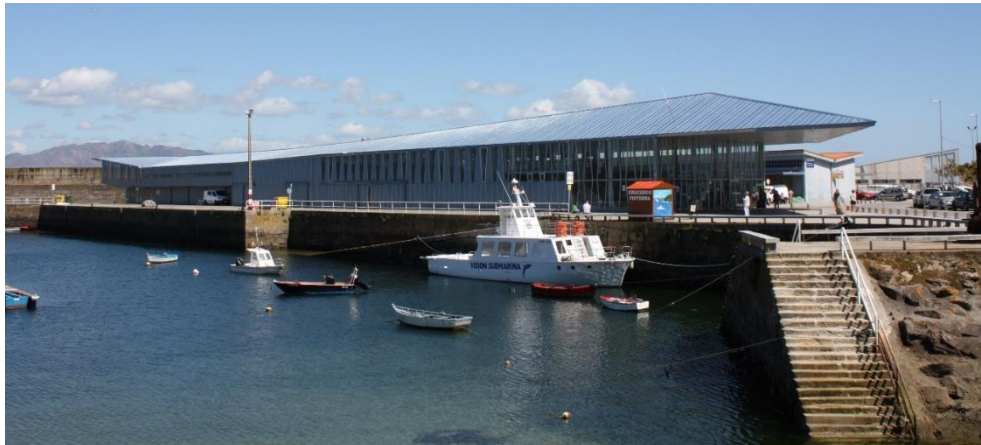
FIGURA N° 59 Vista exterior de Lonja Fiesterra
