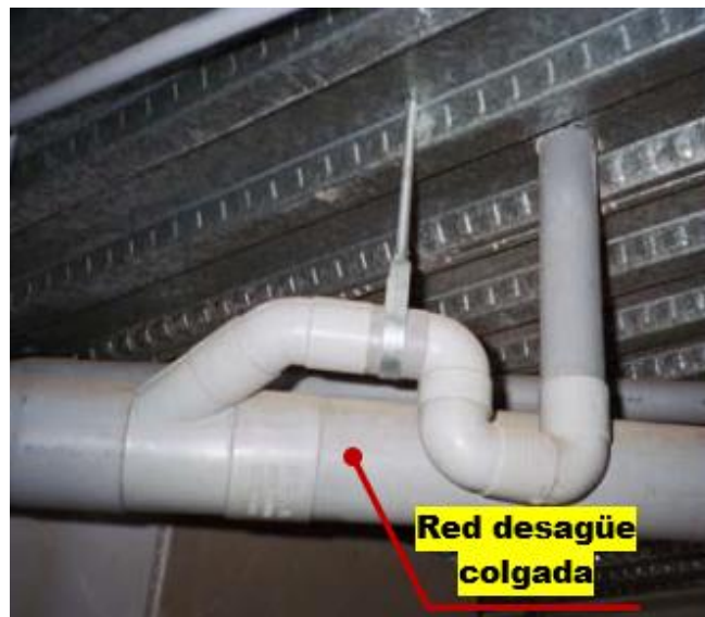
Figura 76. Red de desagüe colgante en losa colaborante
