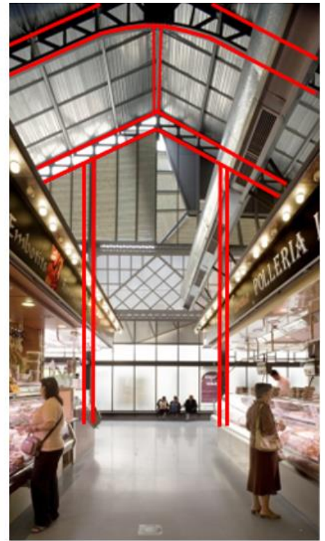
Primer nivel – Estructura metálica
