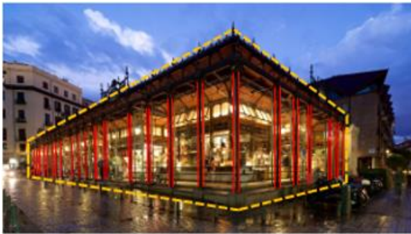
Fachada P - estructura de hierro y cristalería
