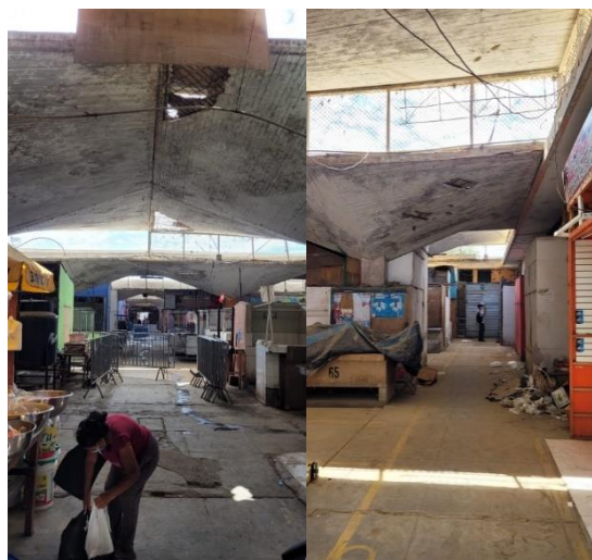
Figura 6. Estado actual interior
