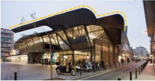
Fachada principal - cubierta metálica
