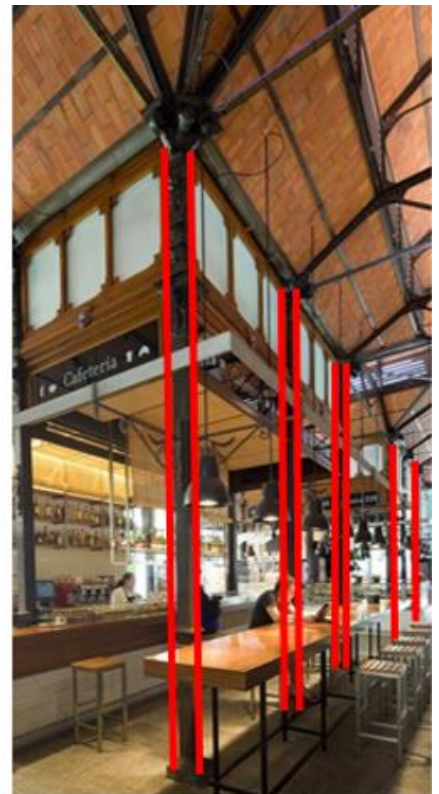
Columnas de hierro de fundición
