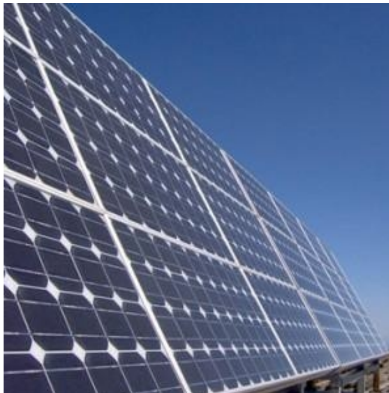
Fotografía N° 4 : Vista de Paneles soles en edificación del Perú
