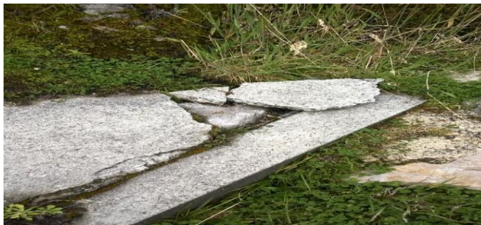
Figura 13. Captación Agrietada
