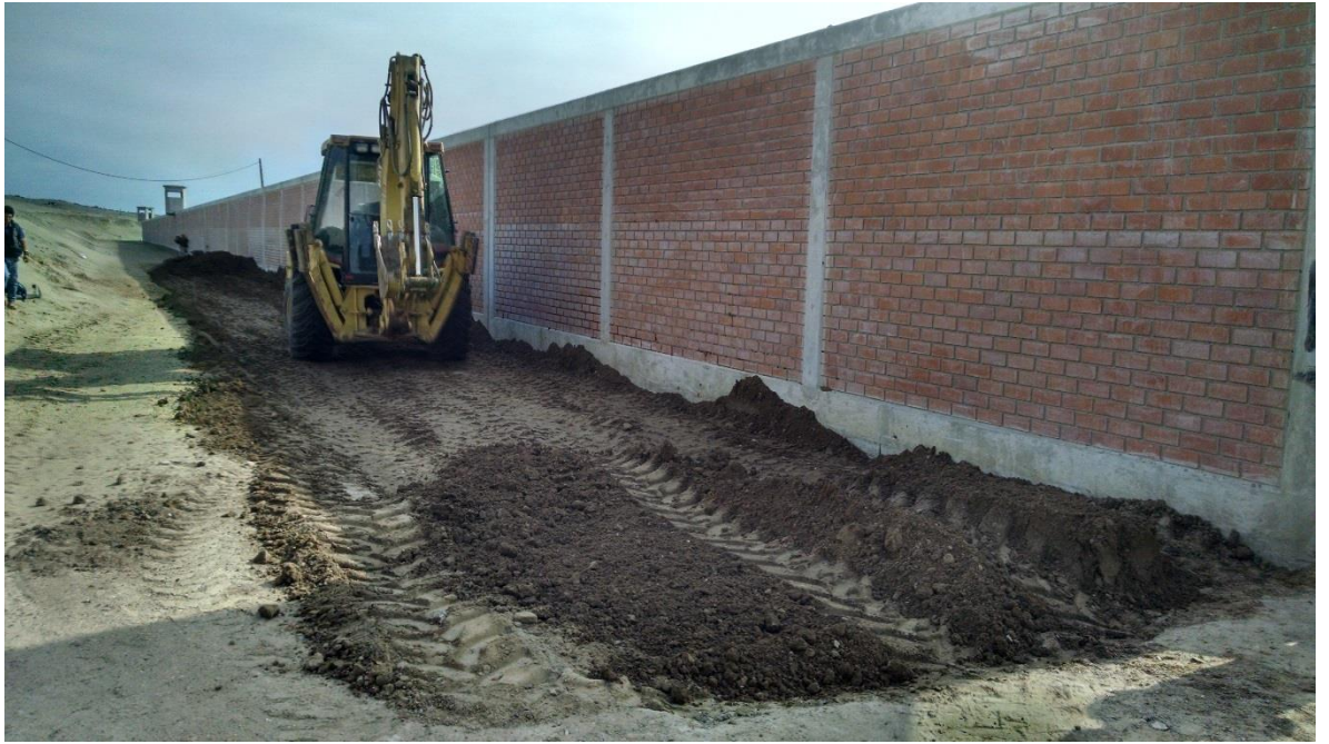
EXTENDIDO DEL AFIRMADO MEZCLADO CON PERMAZYME 11X
