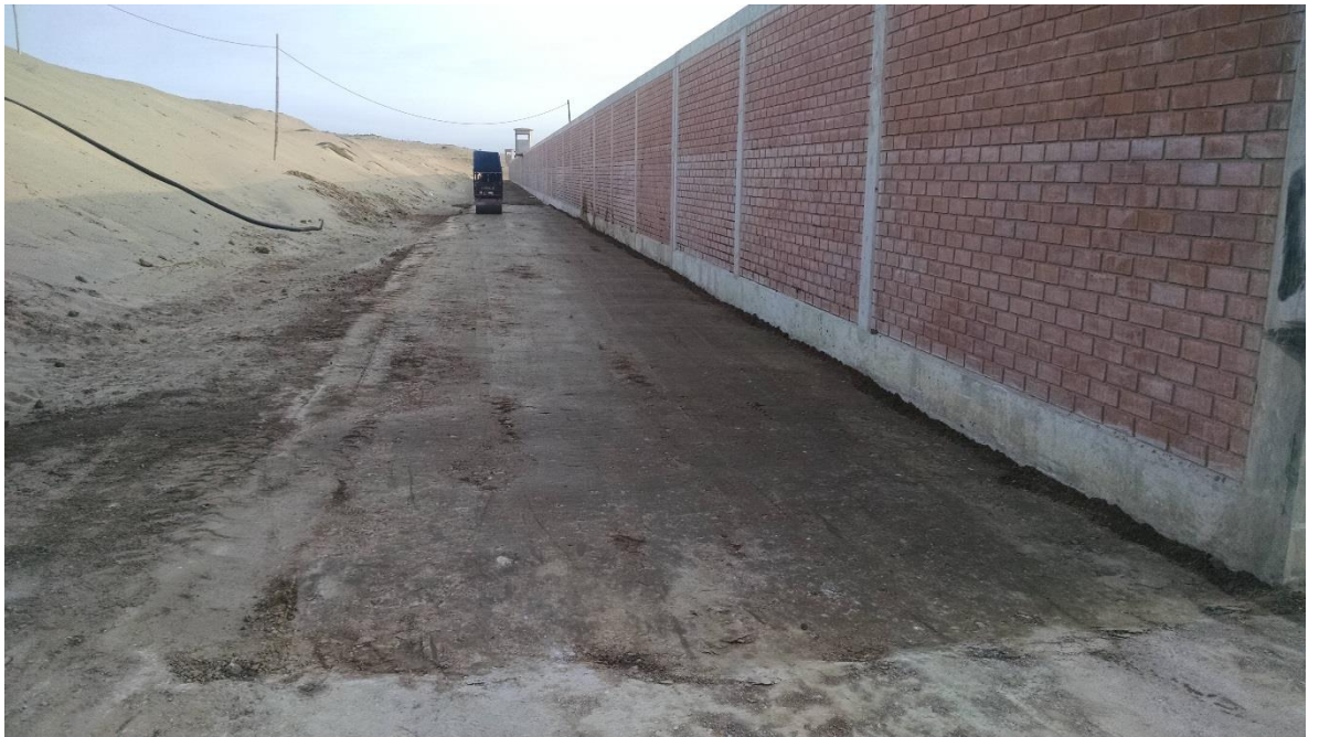
COMPACTACION DE VIA CON AFIRMADO MEZCLADO CON PERMAZYME 11X
