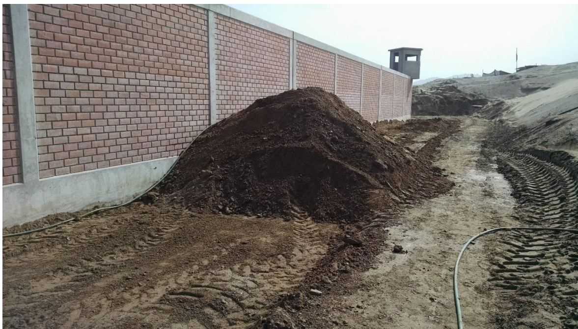
AFIRMADO ARCILLOSO ESCARIFICADO Y REMOVIDO PARA PISTA DE PRUEBA
