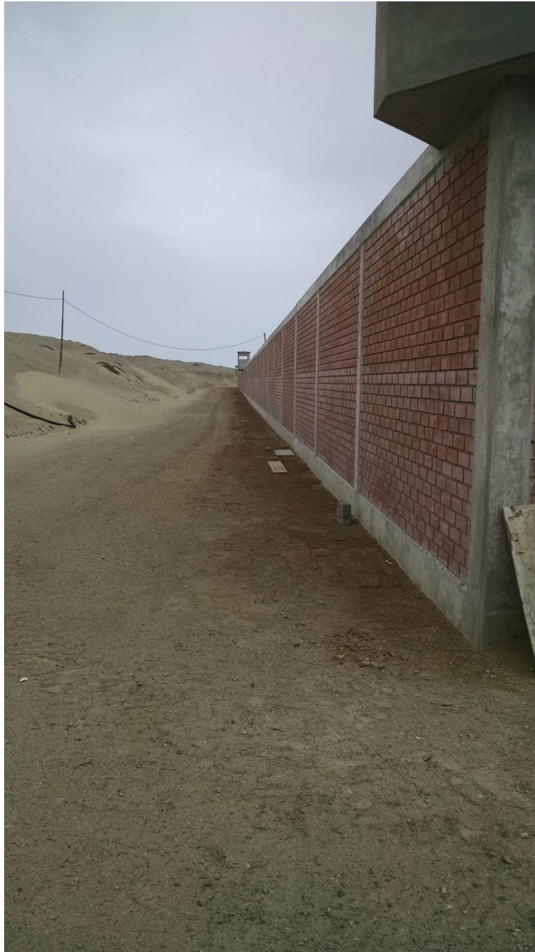
PISTA DE PRUEBA SIN ESTABILIZAR
