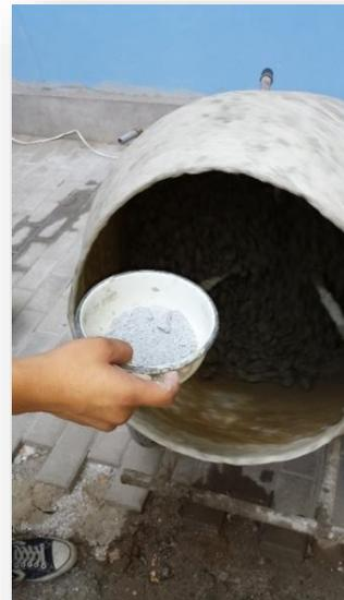
**Figura 12.** Agregando el vidrio molido a la mezcla
