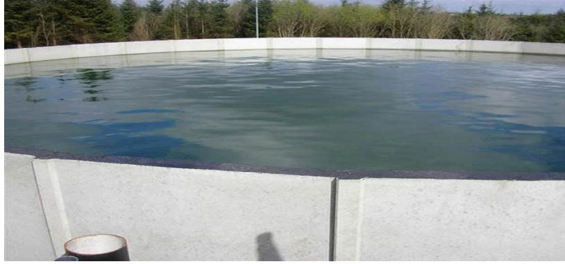
Figura 3. Muro de contención utilizado en un tanque para almacenar agua.
