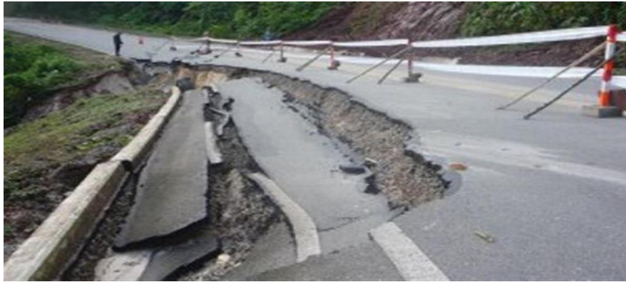
Figura 8: En esta imagen se aprecia cómo se deslizo la carretera por falta de un muro de contención.
