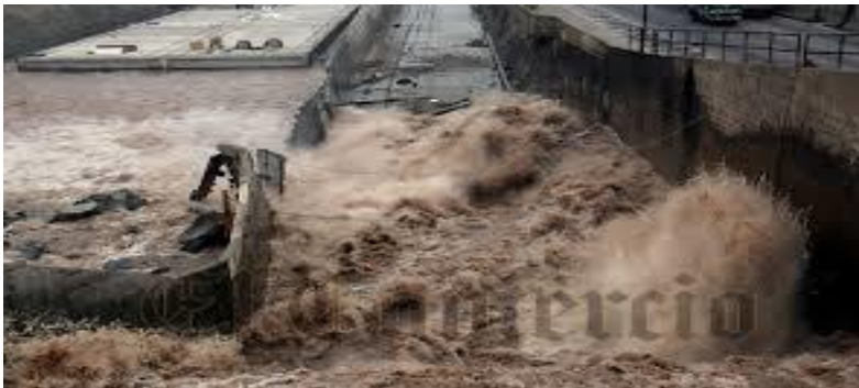
Figura 8: En esta imagen se aprecia cómo se deslizo la carretera por falta de un muro de contención.
