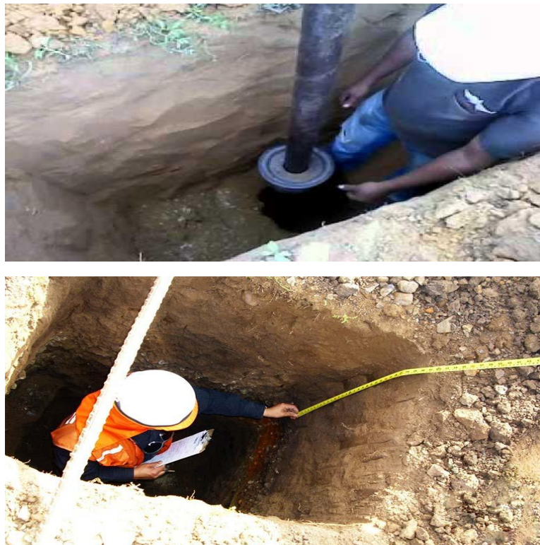
Fig. 3.2 Sondeos y extracción de muestra
