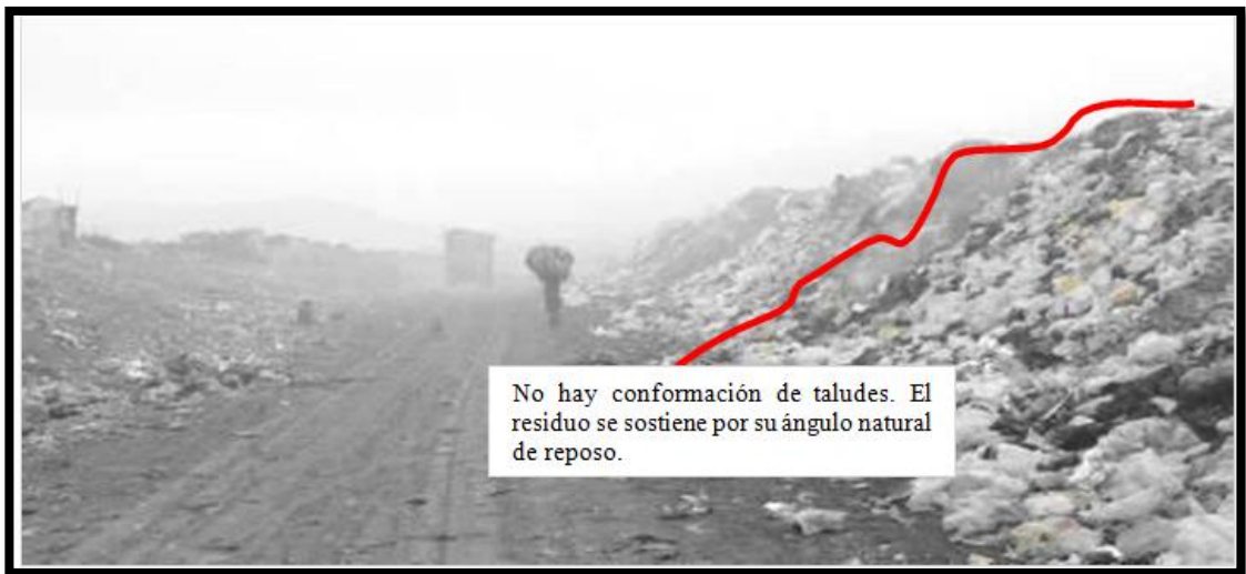
Fotografía 13: Talud de Plataformas en el Botadero de El Milagro.
