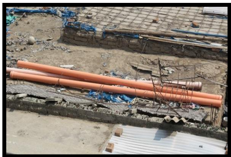
Fotografía 9. Basura en techos
