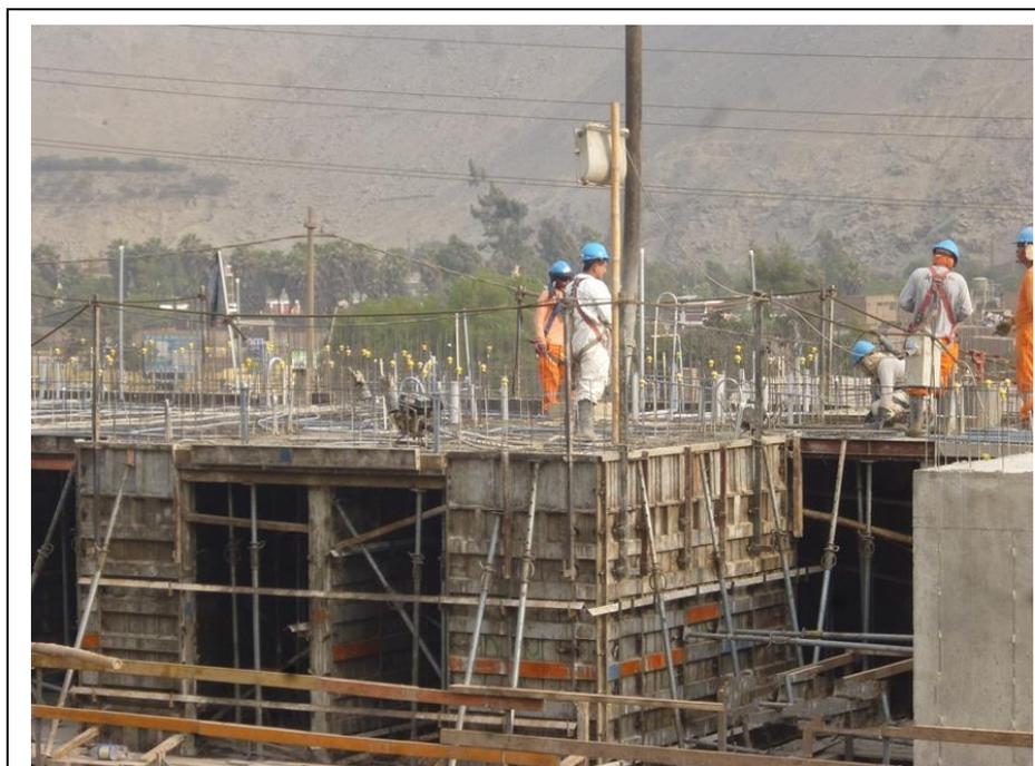
Colocación de concreto en losa y muro Piso N°05
