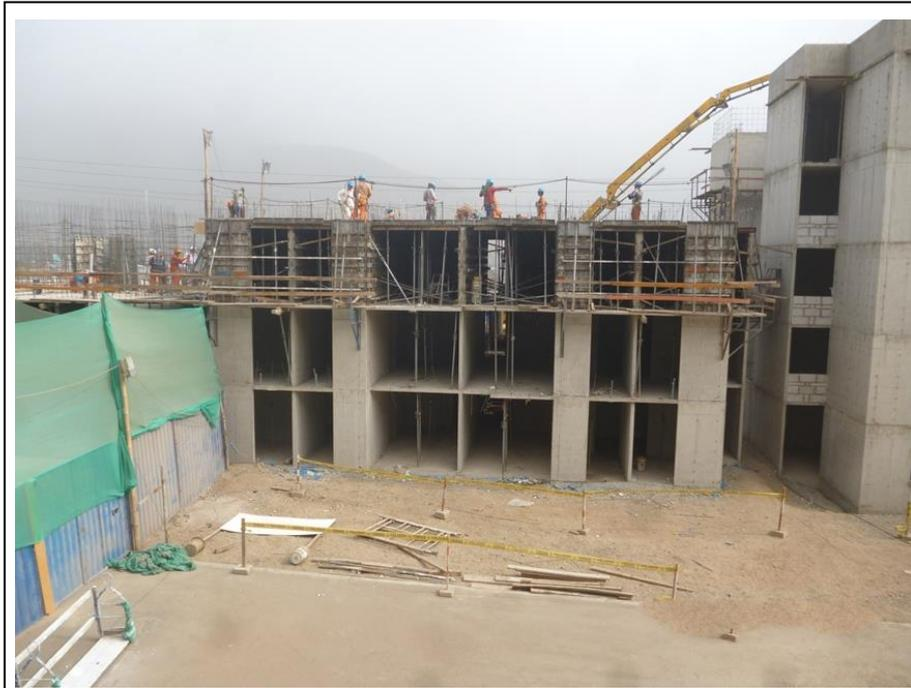
Colocación de concreto en losa techo Piso N°03
