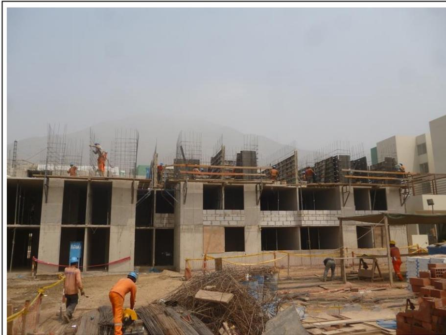
Encofrado de muros Piso N°03
