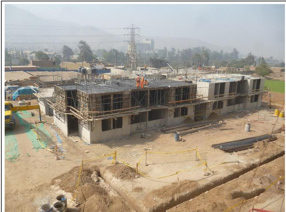
Armado de Encofrado losa Piso N°02
