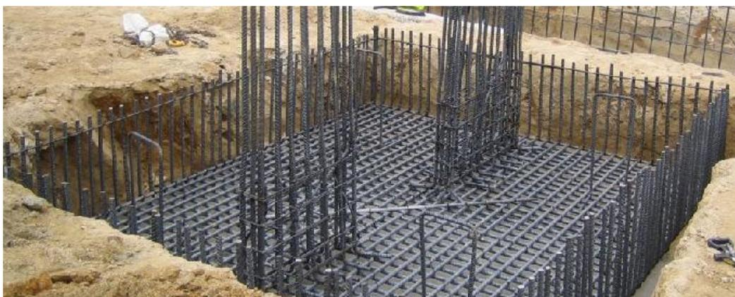
Figura N° 137: Foto de una zapata combinada típica
