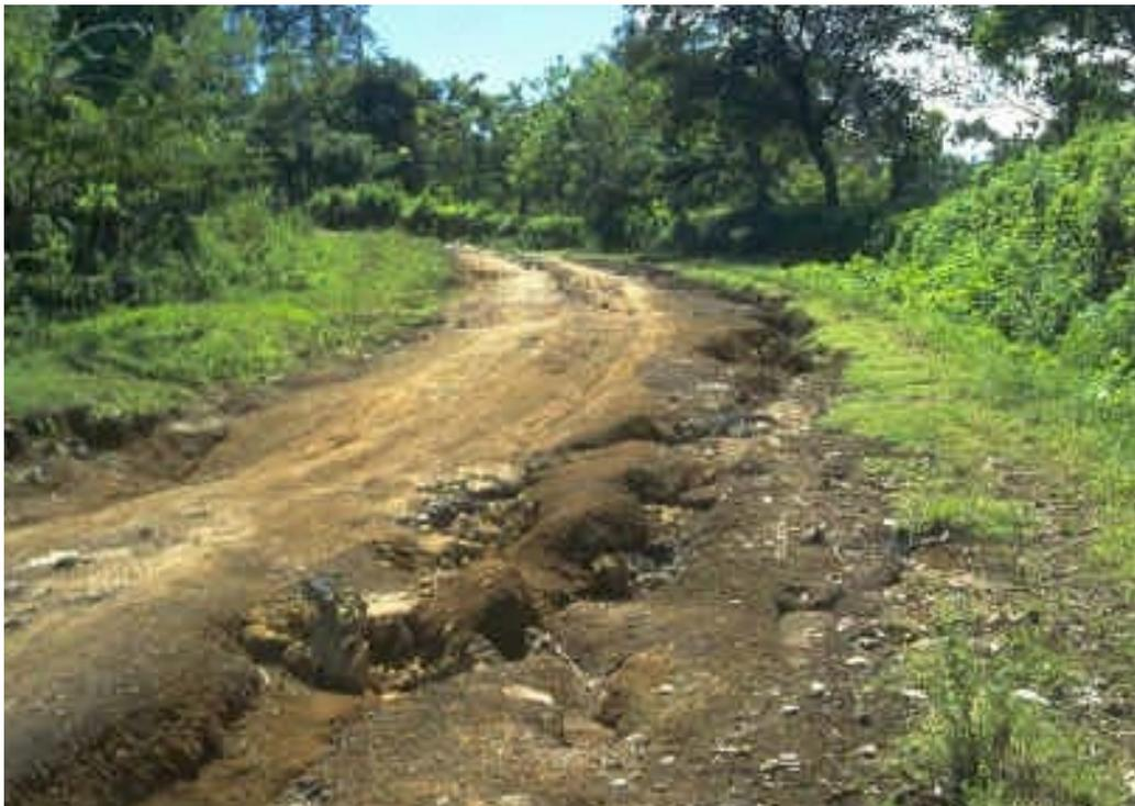
**Fotografía N° 2.06 : Drenaje Inadecuado ( inexistencia de cunetas).Tramo San Benito( Carretera Ascope – Contumaza).**
