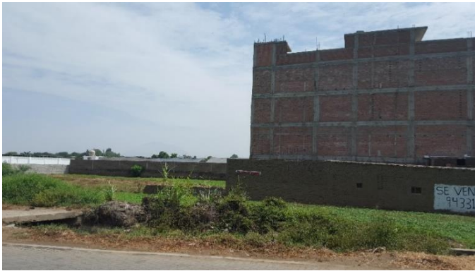
Fotografía 6-18. Edificación de 4 pisos en Camino de Sun
