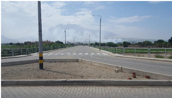
Fotografía 6-12 . Vía de acceso a Urbanización “ Altos del Valle” ampliada y adoquinada
