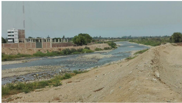
Fotografía 7-2. Edificación de 4 pisos en Ribera del río Moche.
