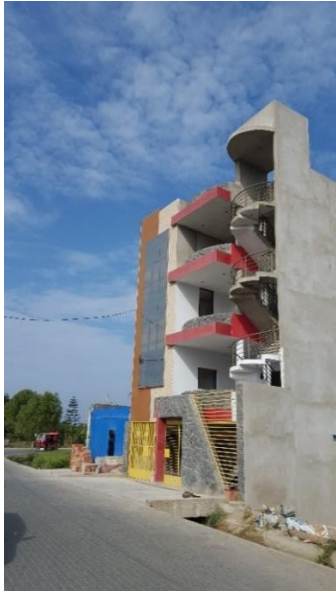
Fotografía 7-1. Edificación de 4 pisos en Camino de Sun.
