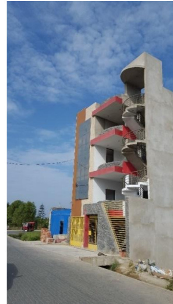
Fotografía 6-19. Edificación de 4 pisos en Camino de Sun
