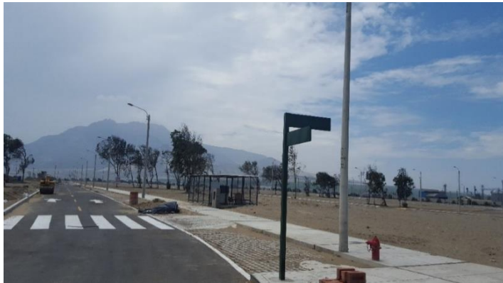
Fotografía 6-14. Vía interior asfaltada en Urbanización “ Altos del Valle” .
