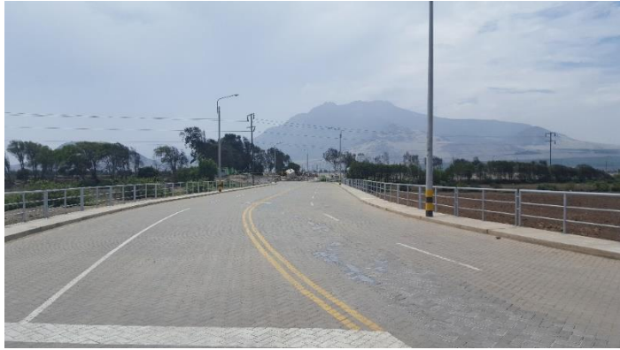
Fotografía 6-13 . Vía de acceso a Urbanización “ Altos del Valle” ampliada y adoquinada
