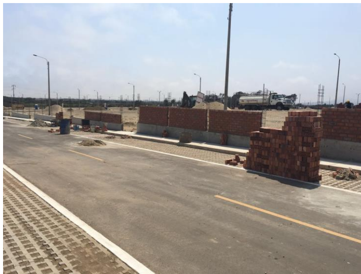
Fotografía 6-15. Vía interior asfaltada en Urbanización “ Altos del Valle” .
