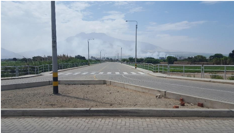
Fotografía 6-38. Nueva vía de acceso a Urbanización Altos del Valle.
