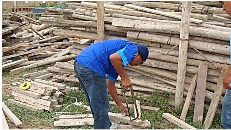
Figura 6. Corte de palos y tablas de madera para el tutorado.
