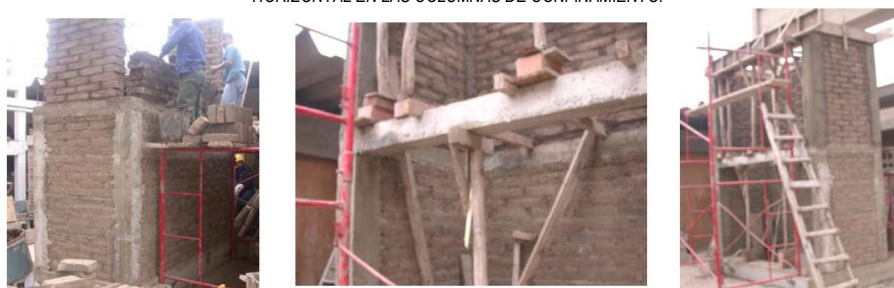
FIGURA 59.3: SECUNCIA DE LA CONSTRUCCIÓN DEL SEGUNDO PISO. EN LA VISTA CENTRAL PUEDE NOTARSE LAS VIGAS DE MADERA TALLADA EMPLEADAS EN CADA NIVEL.
