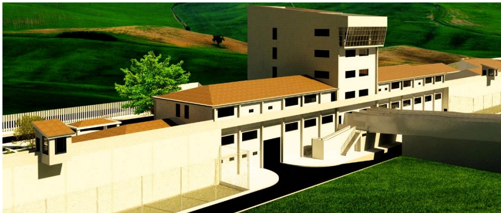
Ilustración 2.82 Fachada posterior del Edificio de control
