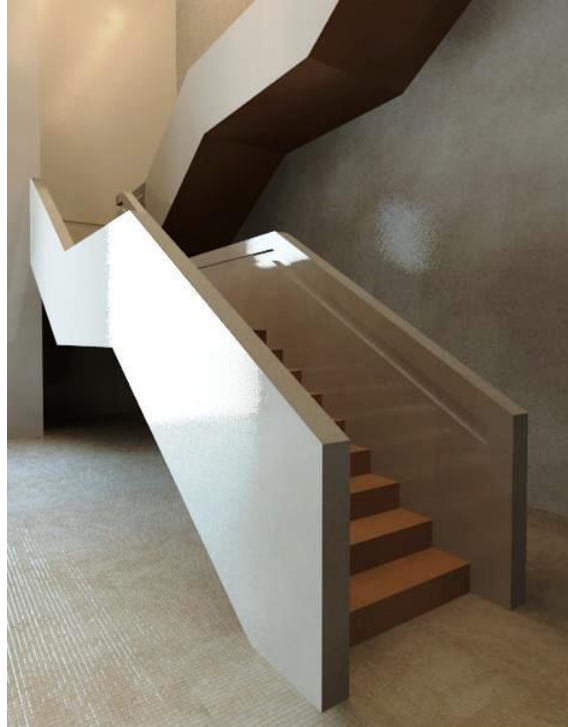
Ilustración 2.97 Pasamano de concreto de escalera del lobby
