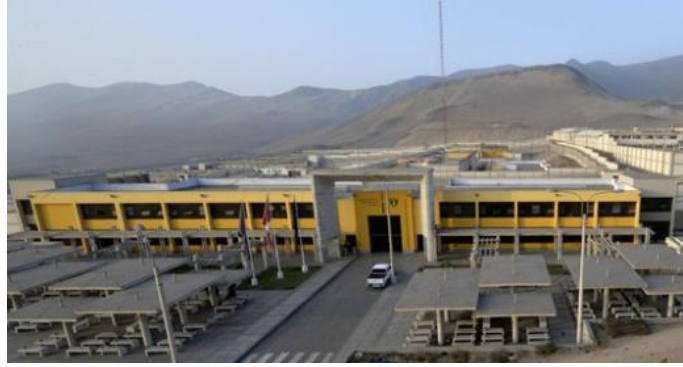
Ilustración 2.7 Fotografía, edificio de ingreso del establecimiento penitenciario Ancón II
