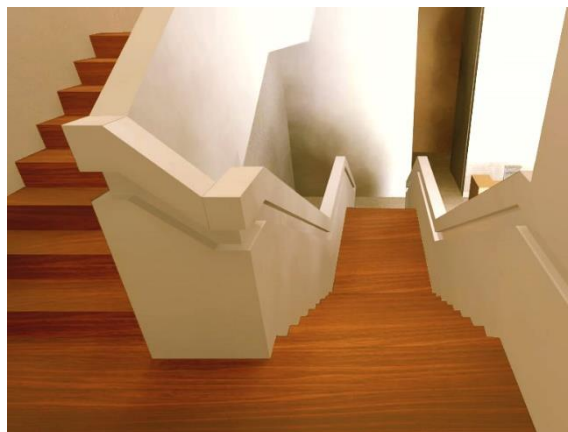
Ilustración 2.98 Destajo en pasamano de escalera del lobby
