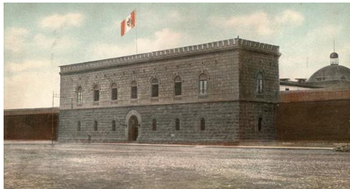
Ilustración 2.8 Edificio de ingreso de la penitenciaría de Lima
