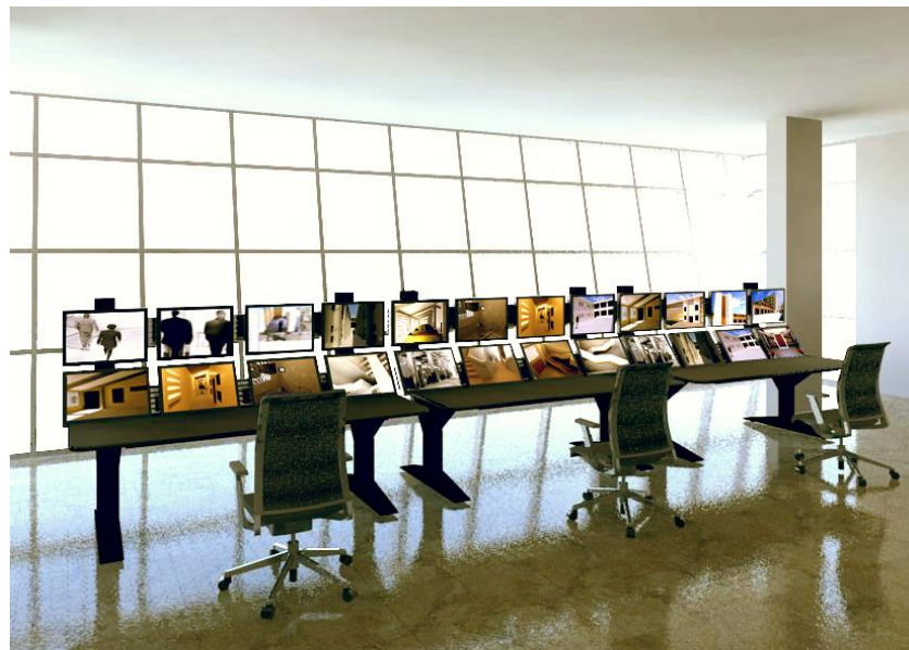
Ilustración 2.54 Sala de control
