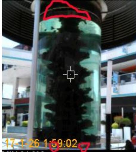
Figura 27: Imagen con zonas de posible generación de corrosión
