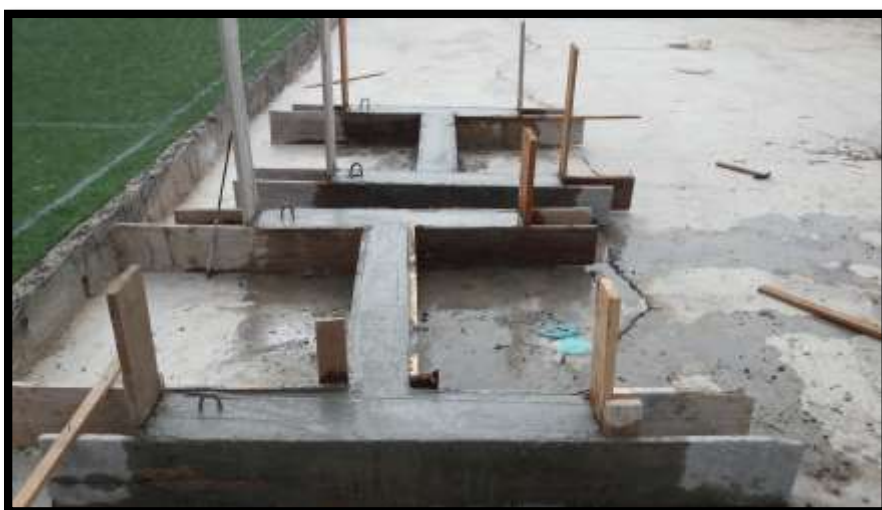
Fig. 2.31. Vaciado del sobrecimiento.
