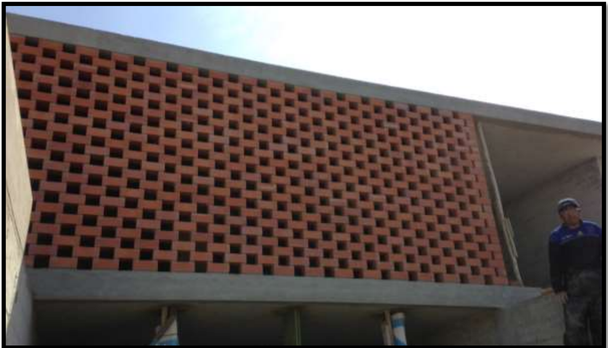
Fig. 4. Muro acabado - 2do Nivel.
