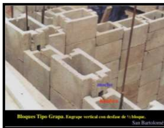
Fig. 2.11. Albañilería de junta seca.
