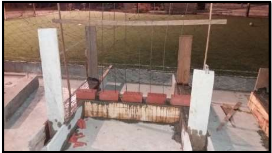
Fig. 2.32. Disposición del acero vertical en el muro.
