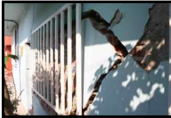
Fig. 2.9. Albañilería No Reforzada.
