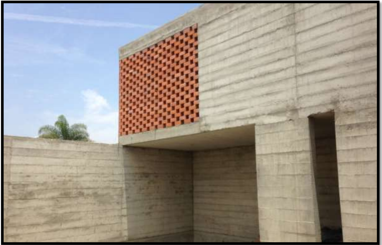
Fig. 5. Muro acabado - 2do Nivel.
