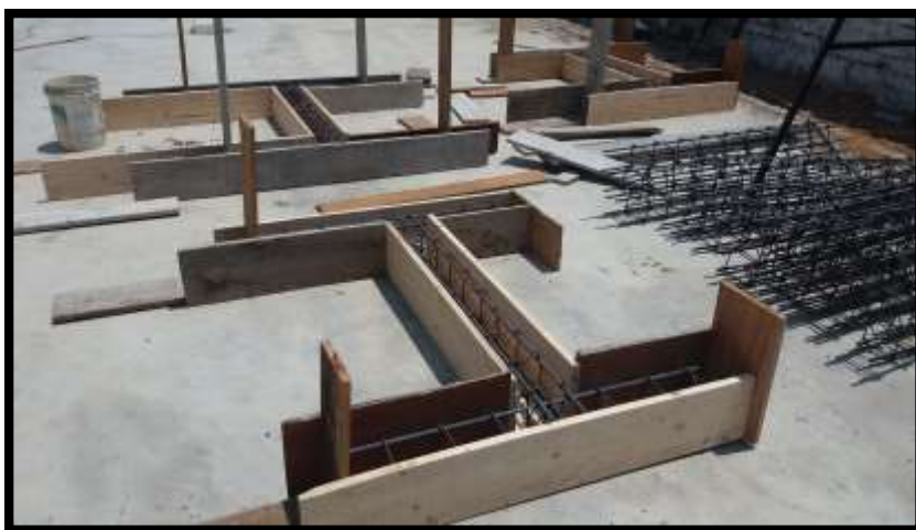
Fig. 2.30. Armado del sobrecimiento.
