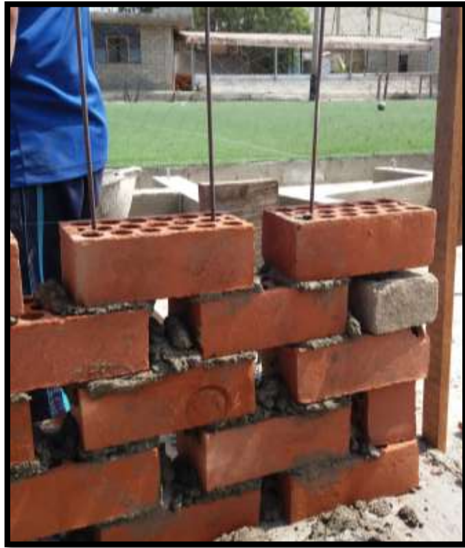
Fig. 2.33. Disposición del acero vertical en el muro.
