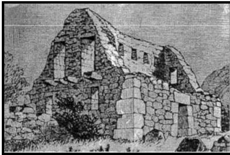
Fig. 2.2. Ollantaytambo. Cusco, Perú (siglo XIV). Esquema de las edificaciones en las laderas. Los muros son de piedra; has sido asentados con barro y recubiertos luego con enlucidos de barro.
