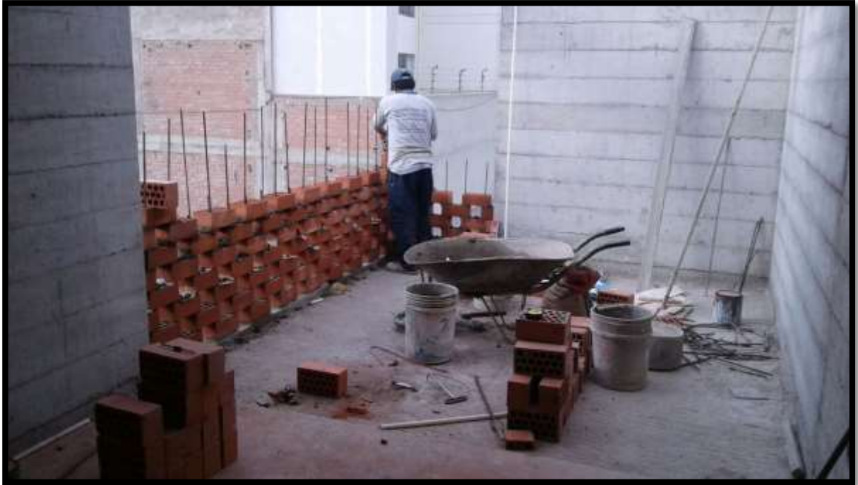
Fig. 1. Construcción del proyecto Real.
