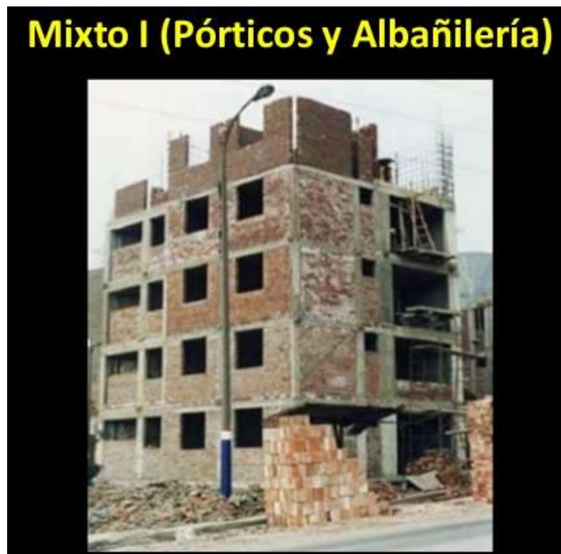
Fig. 2.7. Edificio de Albañilería con Pórticos (mixto)
