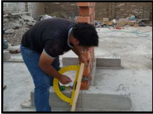
Fig. 2.41. Señalando el eje del muro proyectado al sobrecimiento.
