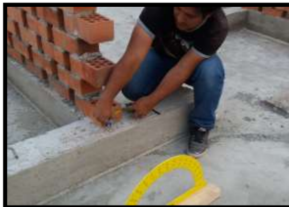
Fig. 2.40. Señalando el eje del muro.
