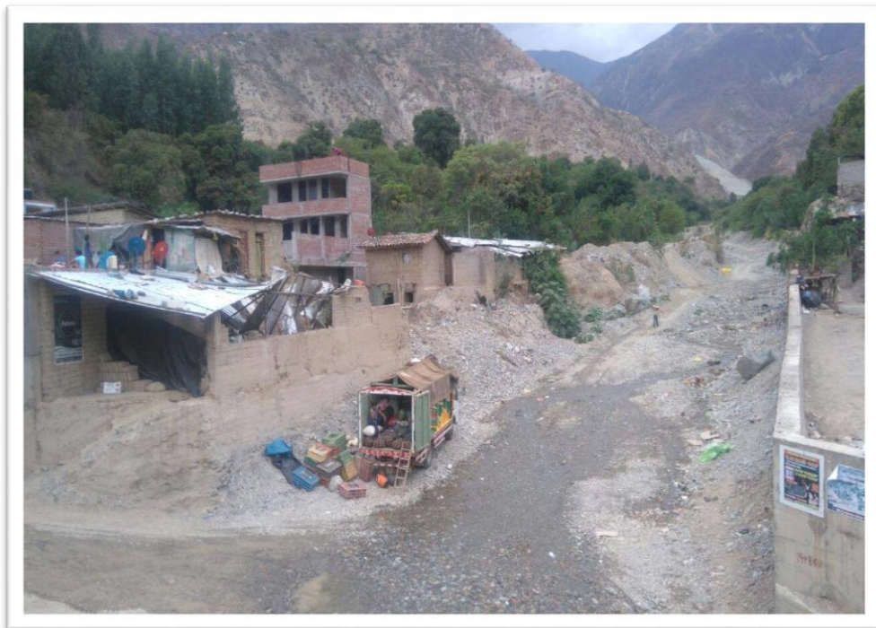
Viviendas existentes en el margen derecho e izquierdo del Rio Tingo
