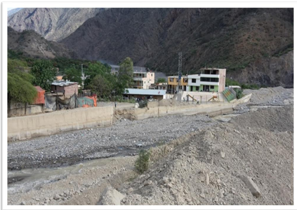
Viviendas y centro recreacional emplazadas a lo largo del margen del rio Tingo.
