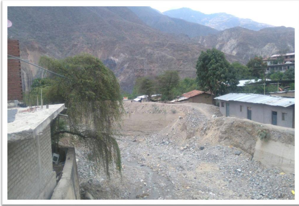
Viviendas existentes sin barreras de protección (muros de contención)
