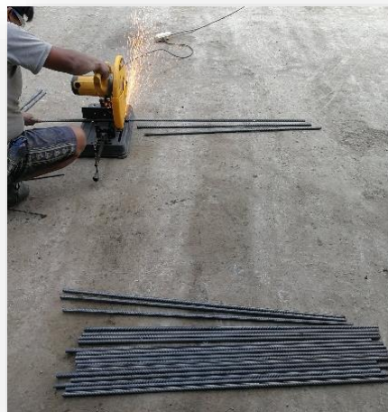
Imagen N° 14. Fotografía cortando el acero de 1/2" para las viguetas de borde.
