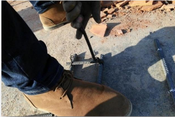
Imagen N° 22. Fotografía del amarre de acero transversal con el longitudinal realizado a las viguetas de borde.
