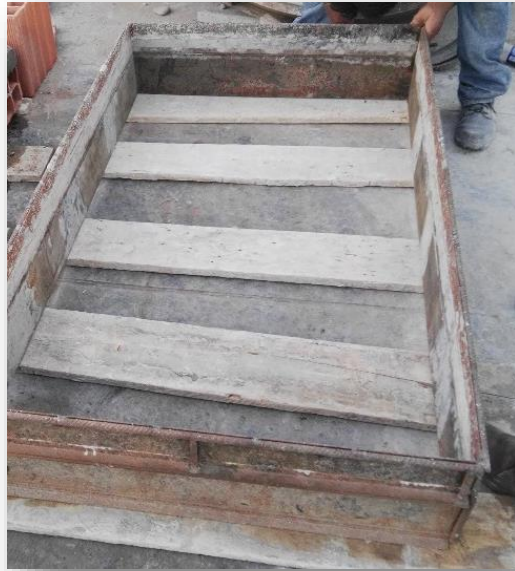
Imagen N° 18. Fotografía del encofrado completo para la losa.
