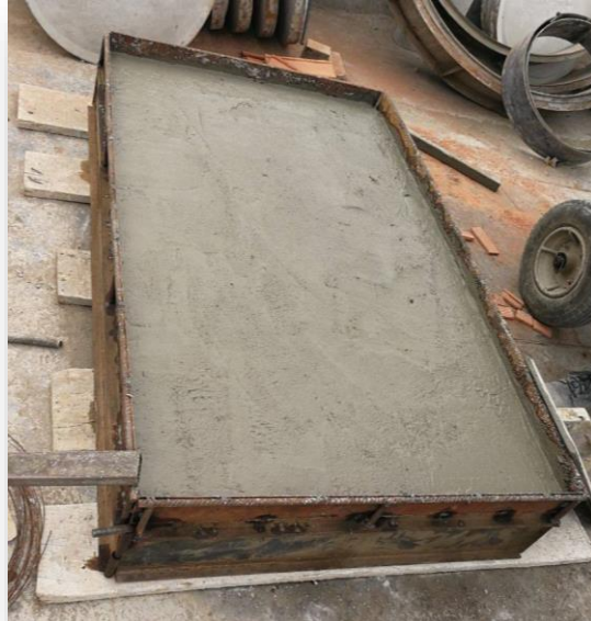
Imagen N° 43. Nivelación de la losa con ayuda de la regla de madera
