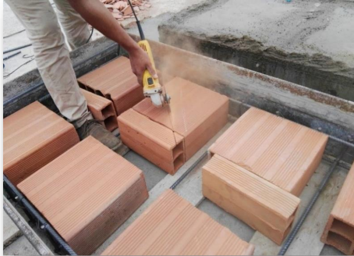
Imagen N° 35. Fotografía en la que se observa el corte de los ladrillos para que pueda pasar la tubería.
