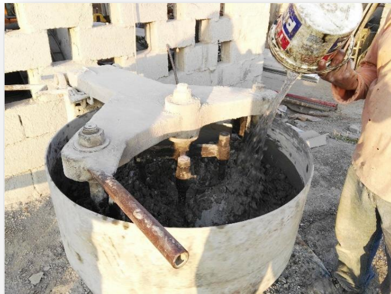
Imagen N° 30. Fotografía del mezclado de los agregados, el cemento y el agua.
