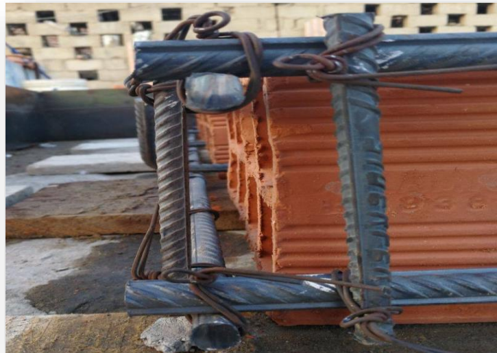
Imagen N° 34. Fotografía en la que se observa los dados de concreto para que evitar el contacto entre el encofrado y los ladrillos.
