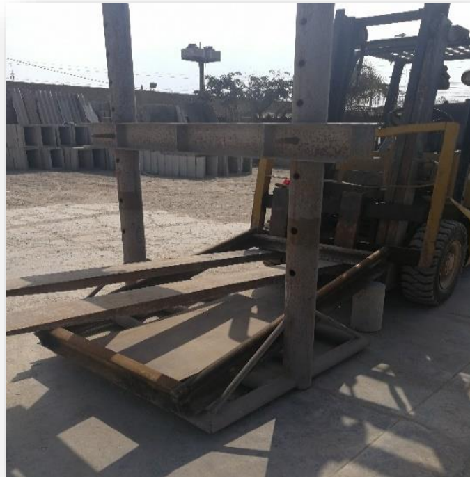
Imagen N° 50. Ubicación de los apoyos con el montacargas, sobre la estructura metálica en la cual se efectuará el desarrollo de los ensayos.
