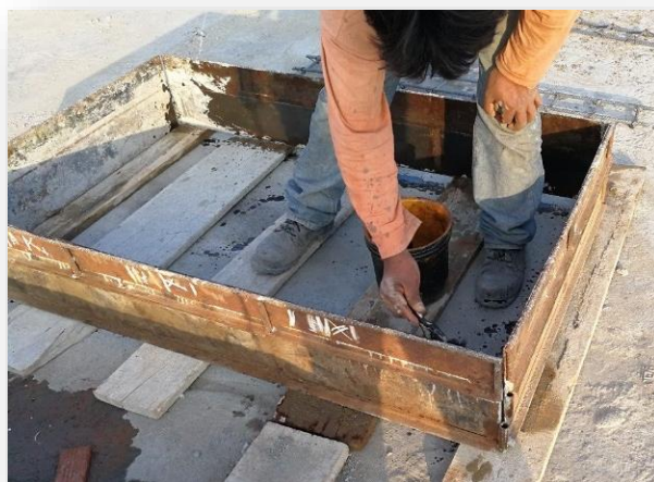
Imagen N° 19. Fotografía del momento en el que se le está aplicando petróleo.
