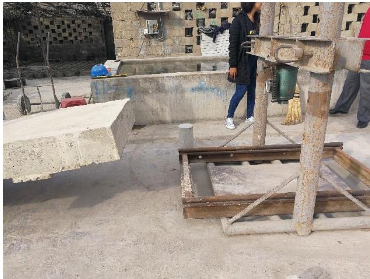
Imagen N° 56. Ubicación de la losa con el montacargas sobre los apoyos de acero en la maquinaria.
