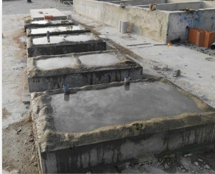
Imagen N° 46. Curado de las losas.
