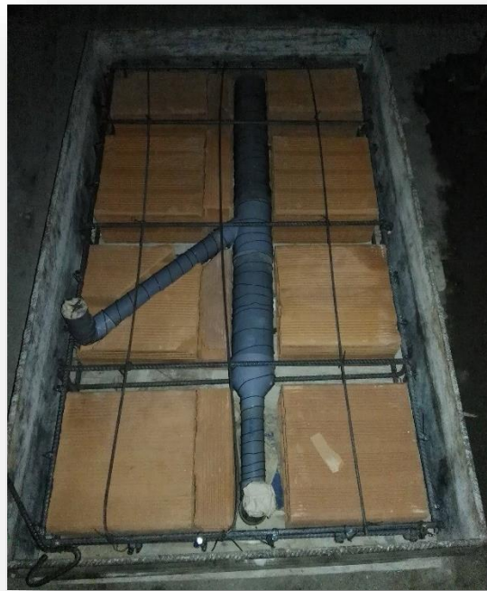
Imagen N° 45. Armado de la losa con tubería perpendicular a la vigueta.
