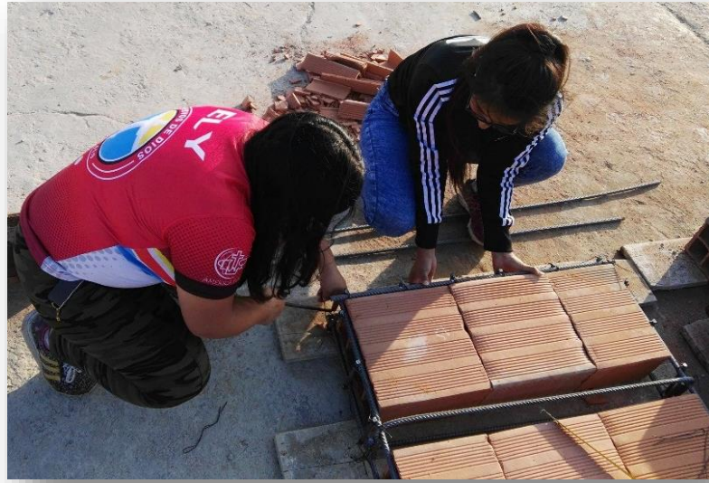
Imagen N° 24. Fotografía amarrando las viguetas de borde.
