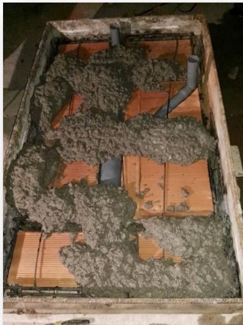
Imagen N° 41. Una vez terminado el diseño de mezcla, se preparó y añadió a la losa.
