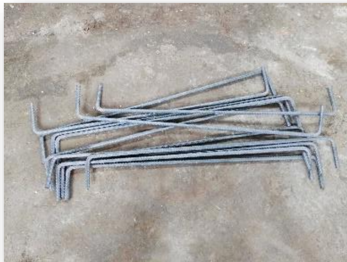
Imagen N° 16. Fotografía de como quedaron las viguetas después de ser dobladas.
