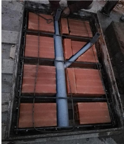
Imagen N° 40. Finalizando el armado de la losa.
