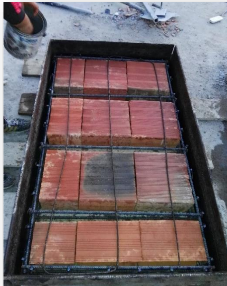
Imagen N° 27. Fotografía del momento en que se rocía agua a los ladrillos antes de colocar la mezcla.
