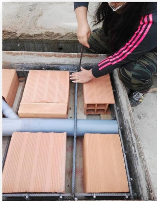
Imagen N° 39. Se utilizó una tortola para amarrar el alambre.
