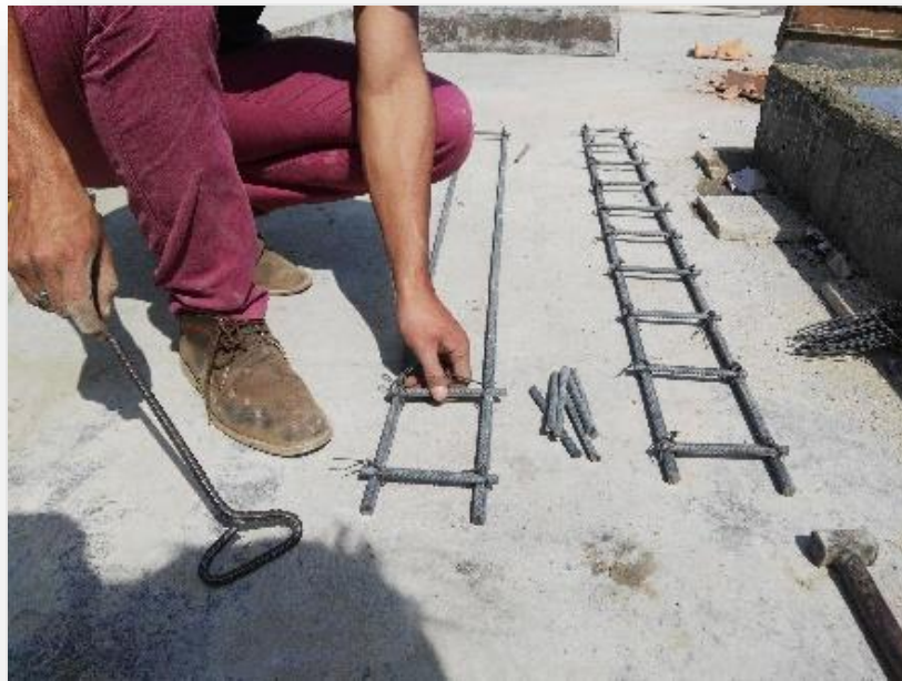
Imagen N° 17. Fotografía del armado de las vigueta de borde.
