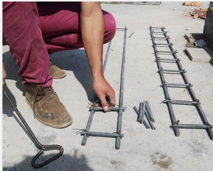
Imagen N° 23. Fotografía armando las vigueta de borde de 1.47 m.
