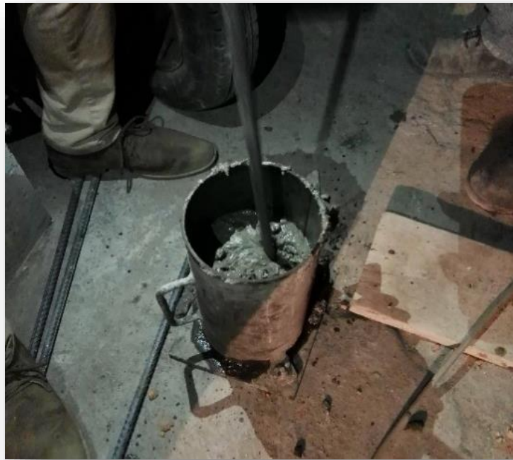
Imagen N° 48. Probeta de concreto a 2/3 de su longitud.
