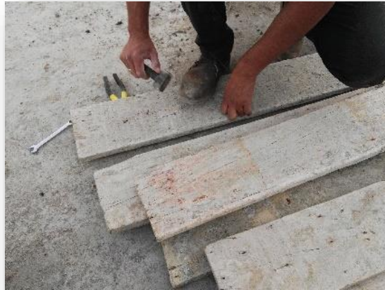
Imagen N° 11. Fotografía de la madera usada para el encofrado de las losas.
