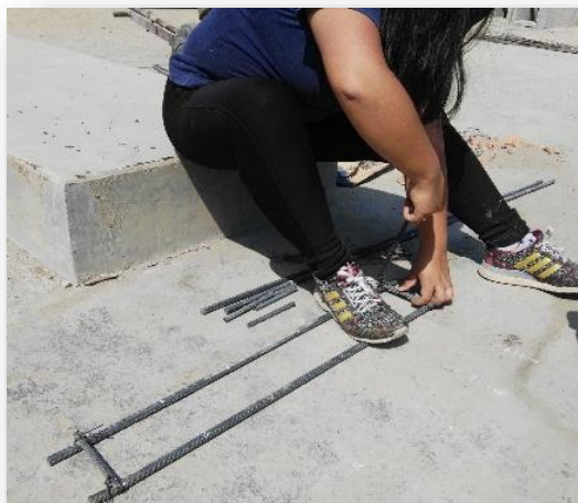
Imagen N° 21. Fotografía armando la viga de borde de 0.87 m.
