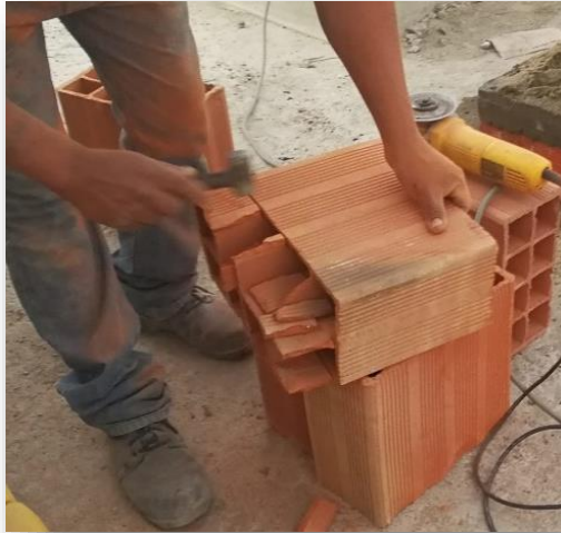
Imagen N° 20. Fotografía cortando el ladrillo para poder colocarlo en la losa.
