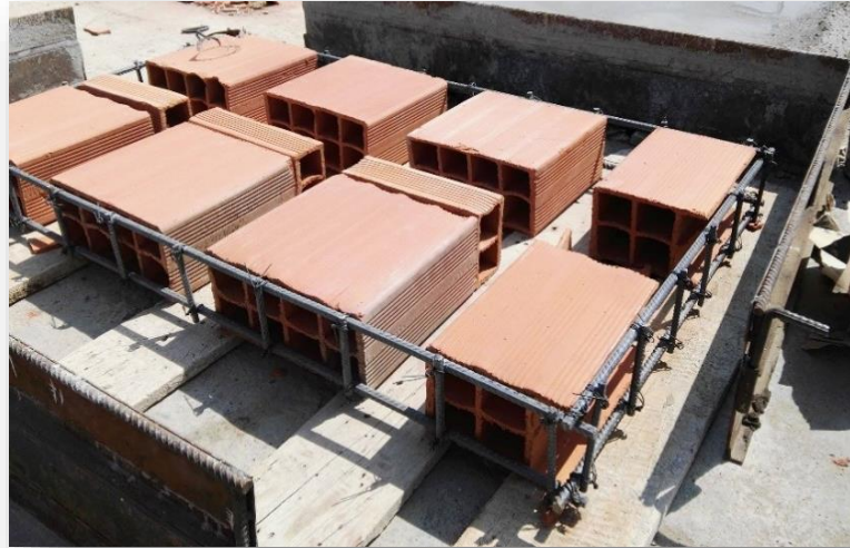
Imagen N° 33. Fotografía de la ubicación del ladrillo y viguetas de borde.
