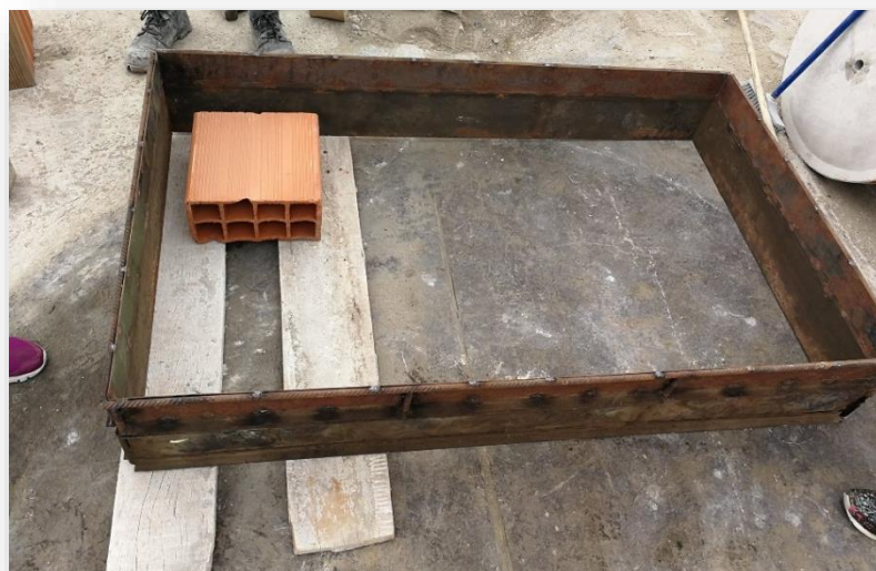
Imagen N° 32. Fotografía de la ubicación del ladrillo y encofrado.
