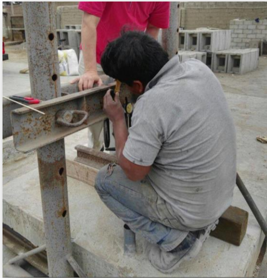
Imagen N° 52. Colocación del gato hidráulico.
