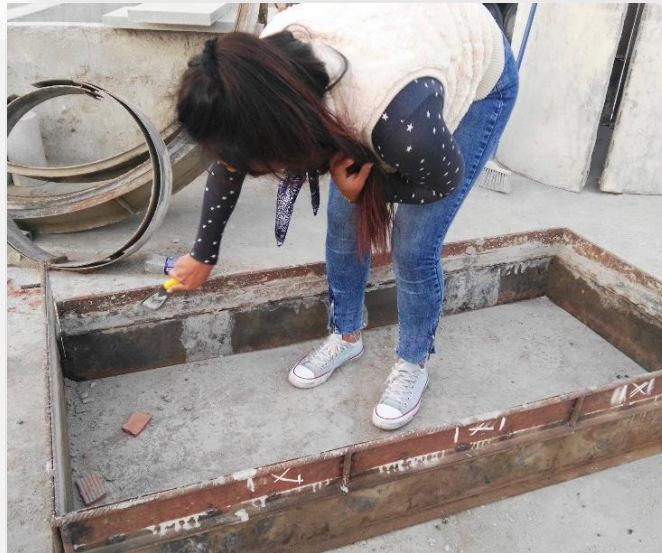
Imagen N° 31. Fotografía de la limpieza del encofrado metálico de la losa.
