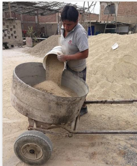
Imagen N° 29. Fotografía del agregado fino usado para la mezcla.
