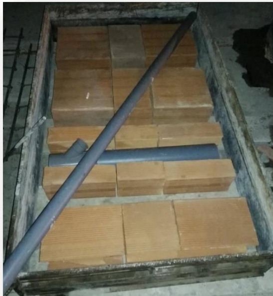
Imagen N° 36. Fotografía en la que se observa el momento en el que se está distribuyendo la tubería para hacer el corte respectivo a los ladrillos.
