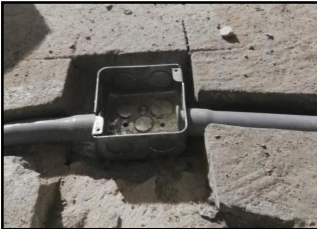
*Colocación de tuberías y cajas para circuitos eléctricos.*
