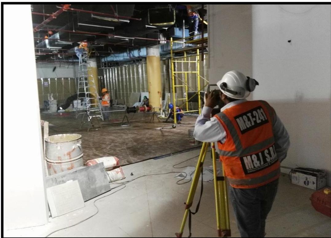
*Verificación de niveles de ductos para HVAC.*
