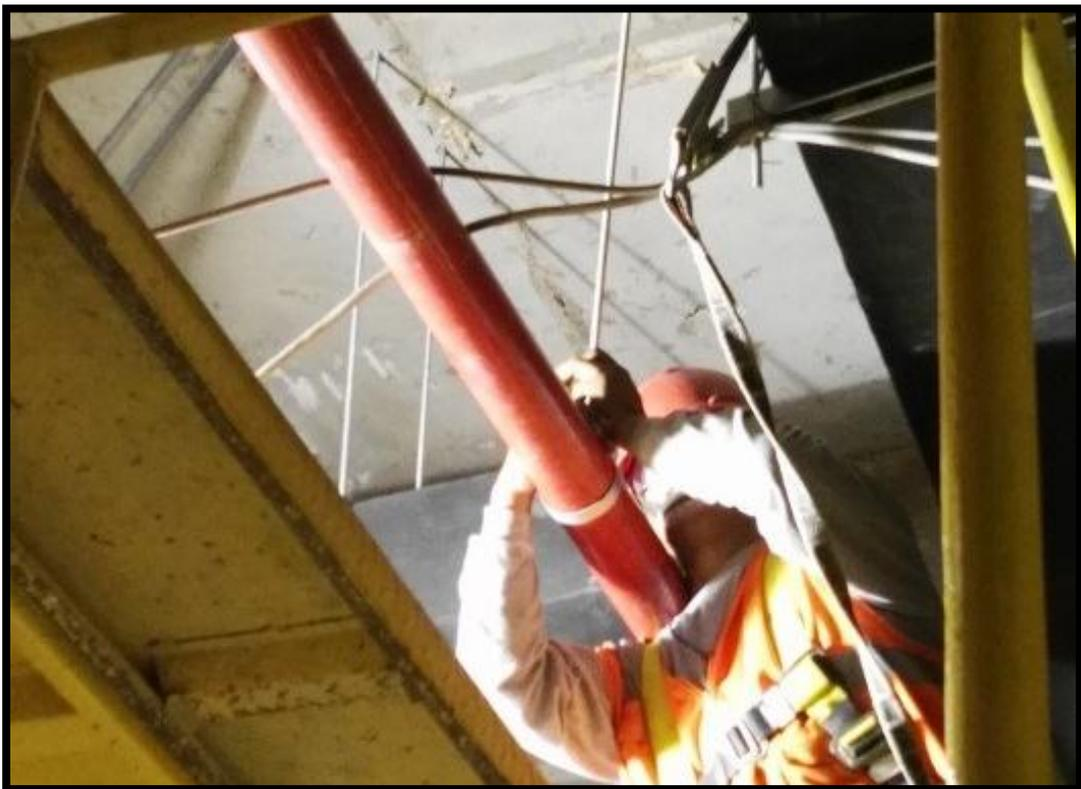
*Colocación de abrazaderas de sujeción para tuberías Agua Contra Incendios.*
