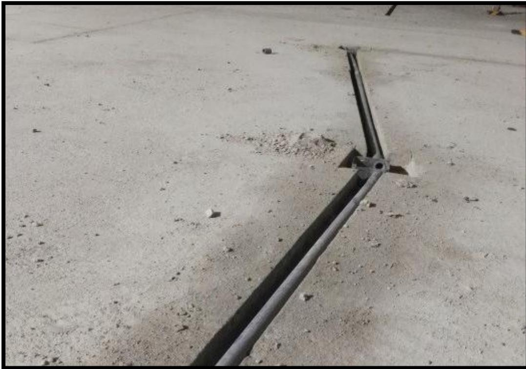
*Colocación de tuberías y cajas para circuitos eléctricos.*
