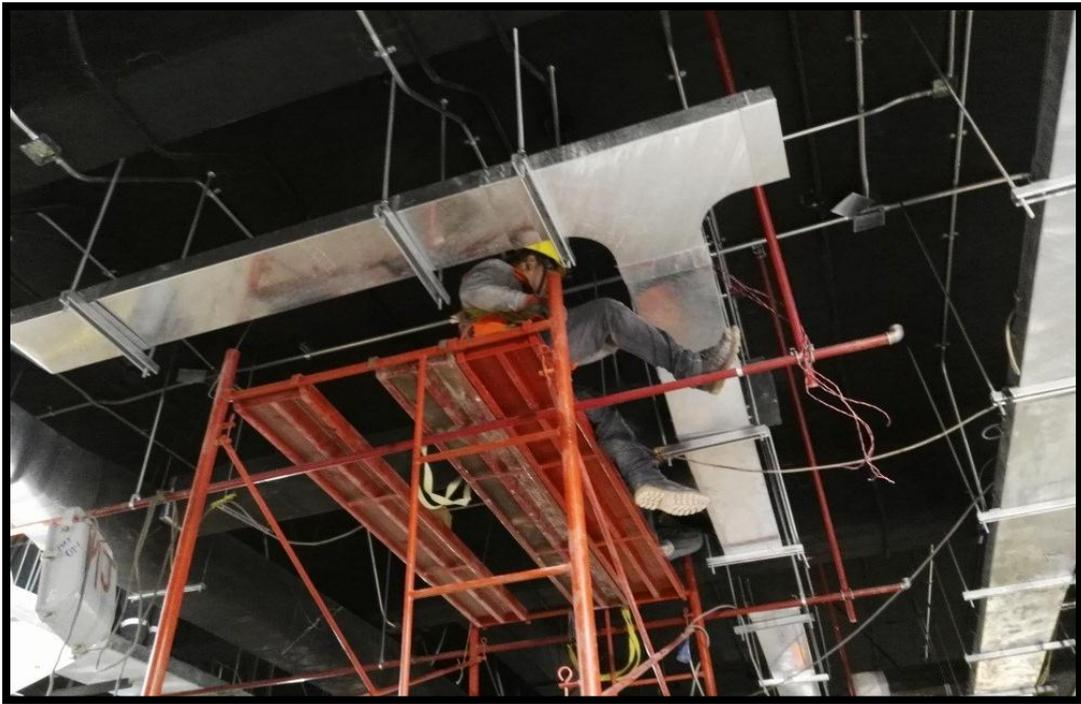
*Instalación de bandejas para circuitos de data*
