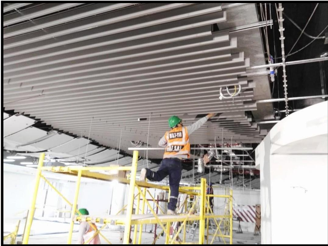
*Instalación de Falso Cielo Raso Lamas.*
