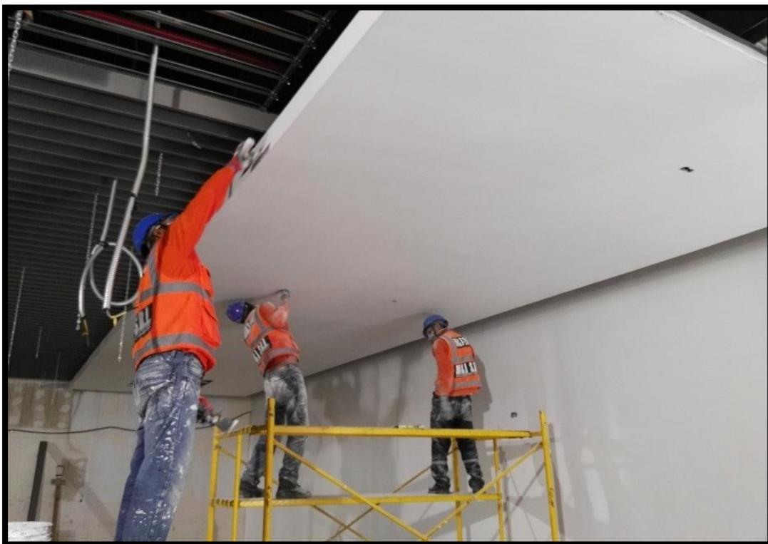
*Colocación de planchas de Drywall en Falso Cielo Raso.*
