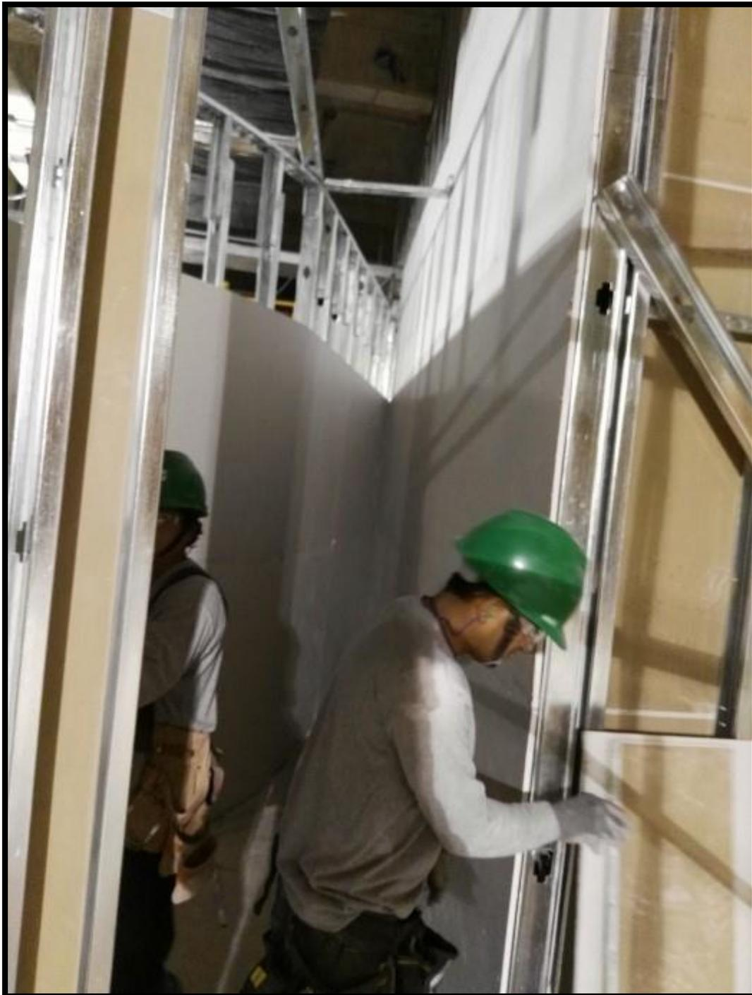
*Colocación de planchas de Drywall en tabiquería.*
