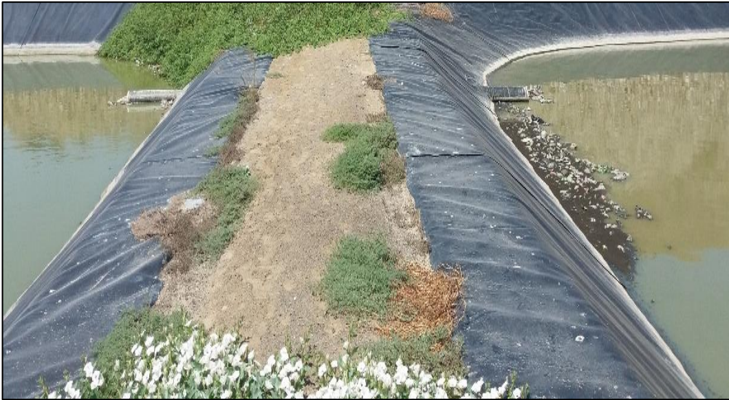
Fotografía n° 9. 6: Laguna de estabilización existente
