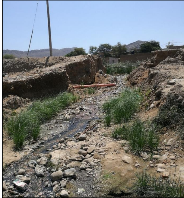
Fotografía n° 9. 1: Flujo de aguas servidas en el centro poblado Ciudad de Dios
