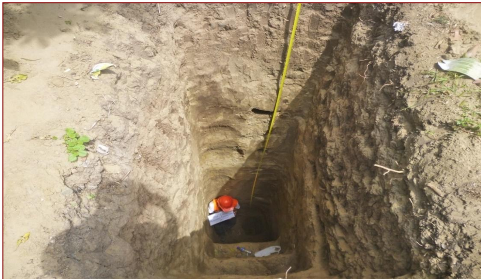
FOTO 8: Vista de la Calicata realizada por SL DE INGENIERIA EIRL, en la Urb. UPAO 2 (ZONA III)
