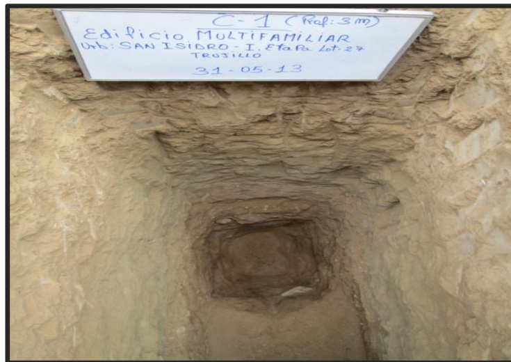
FOTO 4: Vista de la Calicata realizada por SL DE INGENIERIA EIRL en la Urb. San
