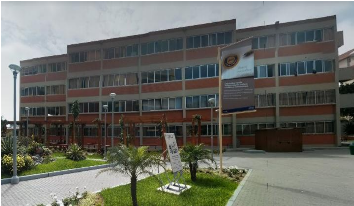
Foto 12: Vista Frontal (Elevación de la Edificación)
