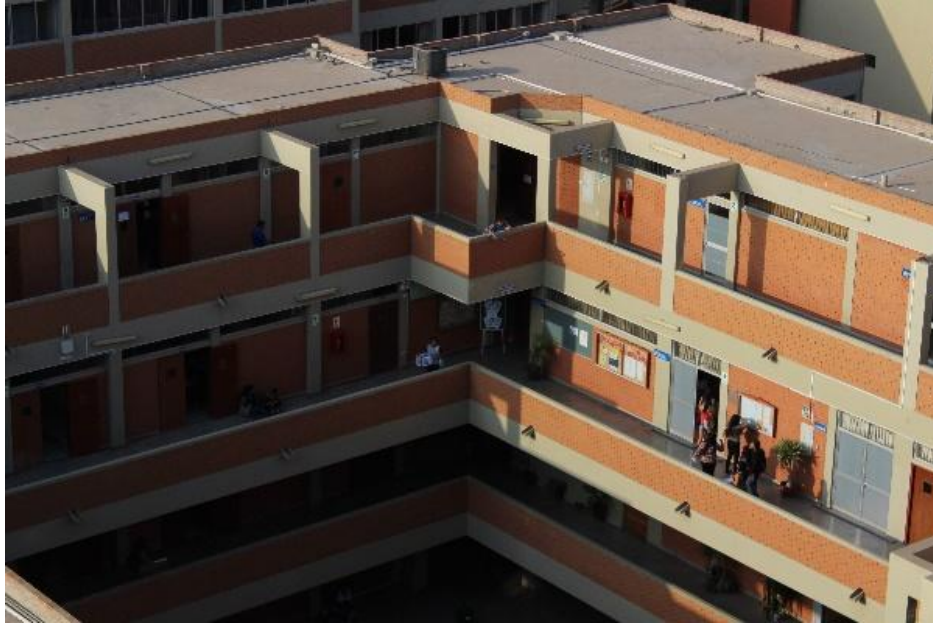
Foto 14: Vista Panorámica del Pabellón D (Cubierta y Elementos estructurales)
