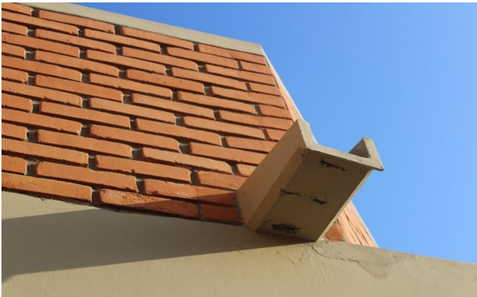
Foto 16: Vista de una gárgola
