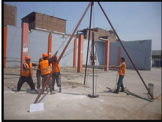
FOTO 2: Vista del Ensayo de Penetración Estándar (SPT), realizado por SL DE INGENIERIA EIRL en el Centro Comercial Plaza Veá – Av. España.
