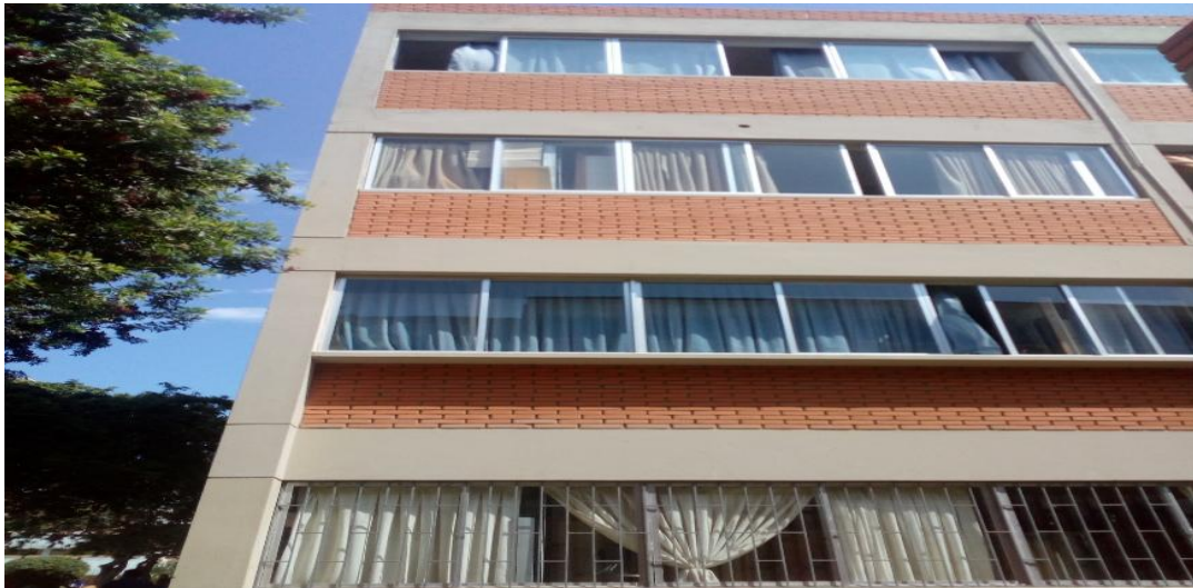
Foto 11: Vista de Elementos estructurales
