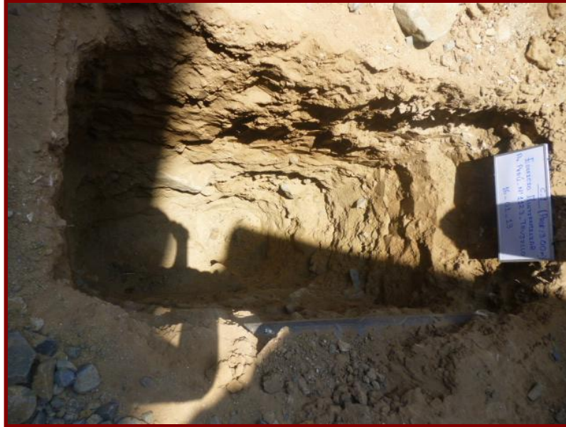
FOTO 6: Vista de la Calicata realizada por SL DE INGENIERIA EIRL, en la Av. Perú (Zona II)
