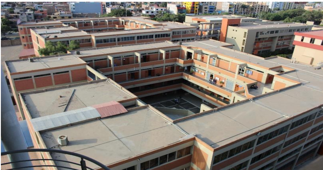
Foto 13: Vista Panorámica del Pabellón D (Cubierta del Edificio)
