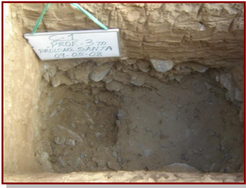
FOTO 5: Vista de la Calicata realizada por SL DE INGENIERIA EIRL, en la Av.
