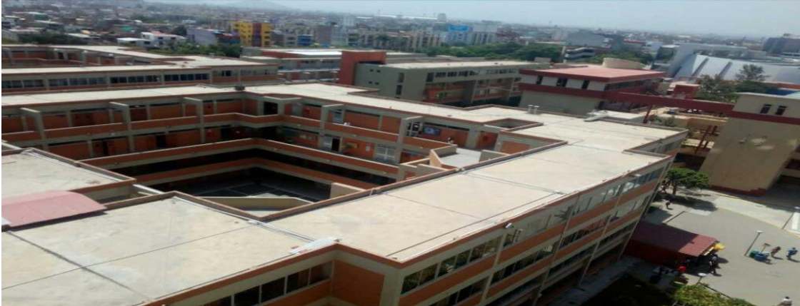
Foto 10: Vista Panorámica de la Edificación
