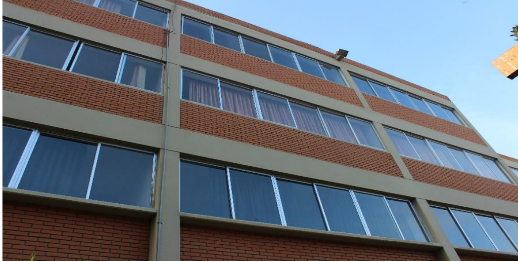
Foto 4: Vigas y Columnas del Pabellón D - alineación
