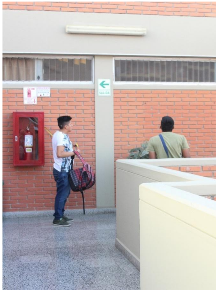
Foto 5: Inspección a los Muros de albañilería del Pabellón D
