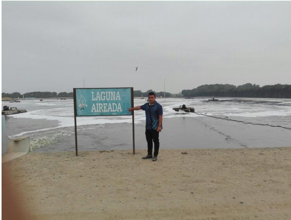
Planta de Tratamiento de Aguas Residuales de Covicorti.
