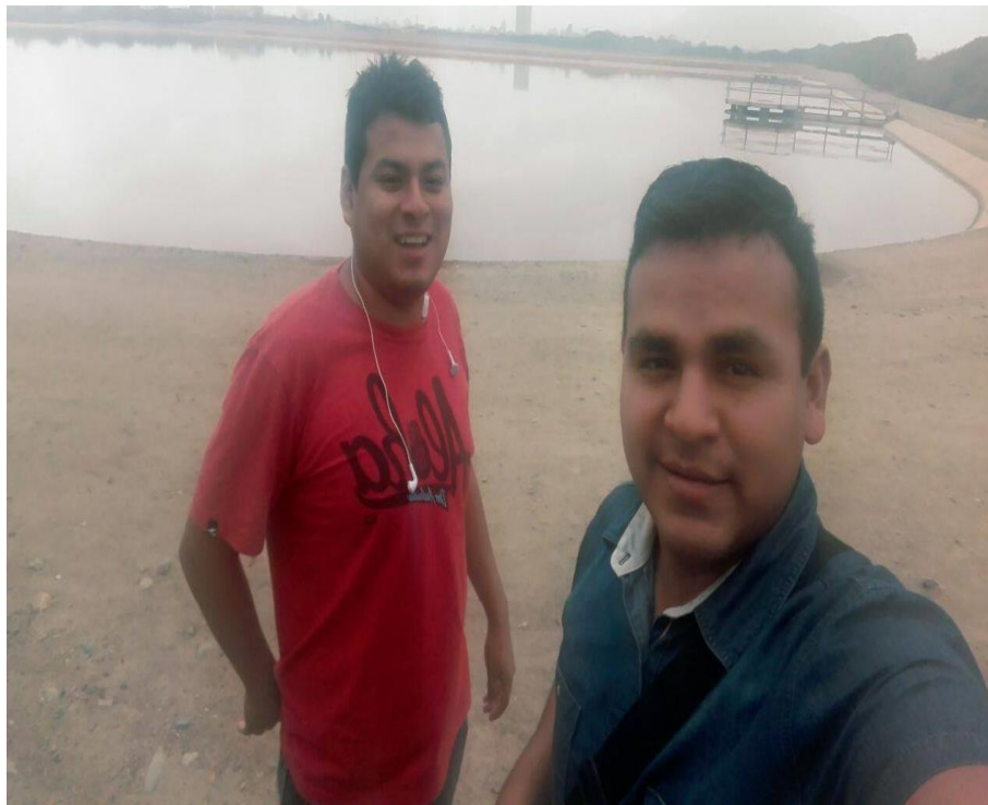
Planta de Tratamiento de Aguas Residuales del Cortijo.
