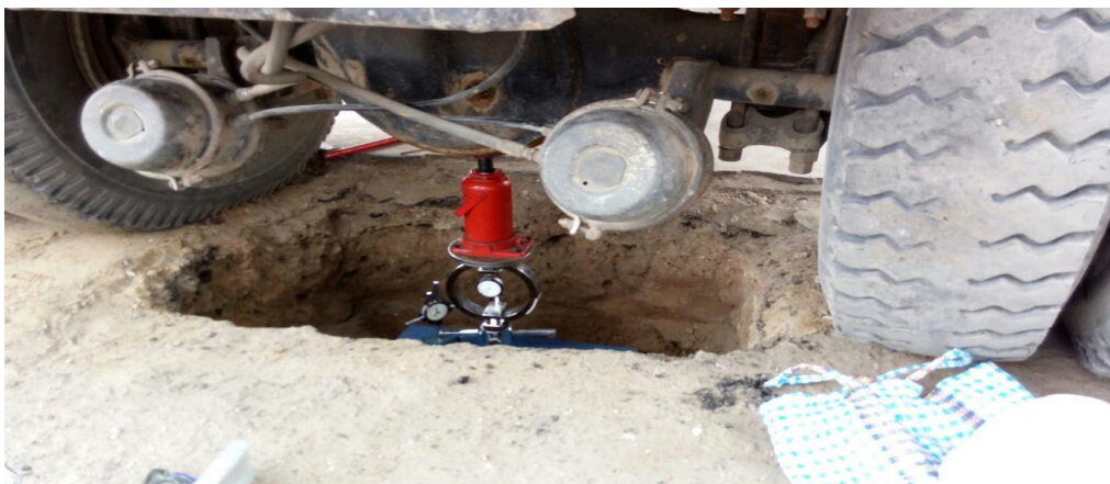
Foto N°01: Ensayo CBR in situ
