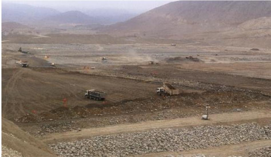
*Figura 17. Sector de descarga de material de cantera en plataforma de la Presa aguas abajo*
