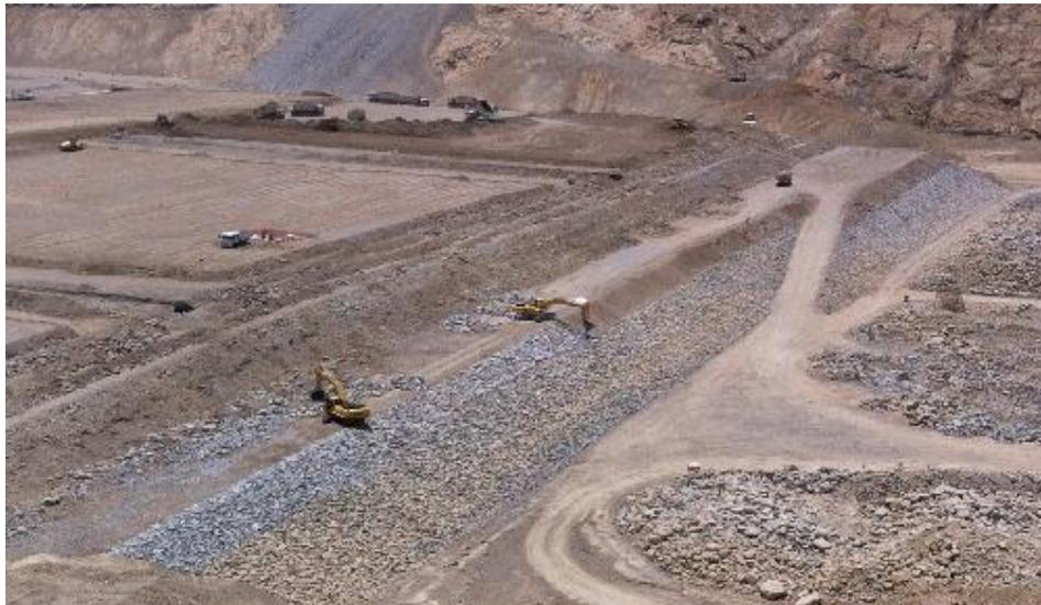
*Figura 16. Sector de descarga de material de cantera en plataforma de la Presa MI
