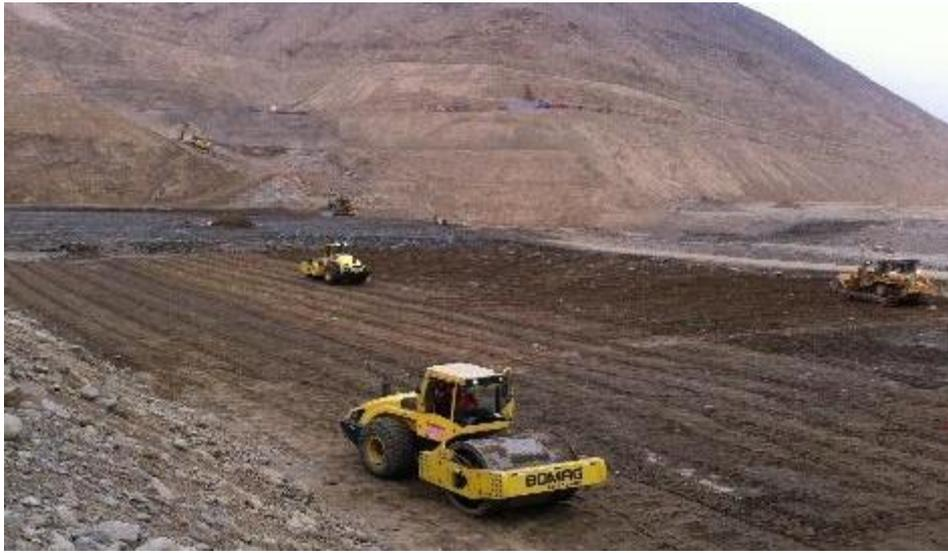
*Figura 15. Sector de conformación y compactación en plataforma de la Presa
