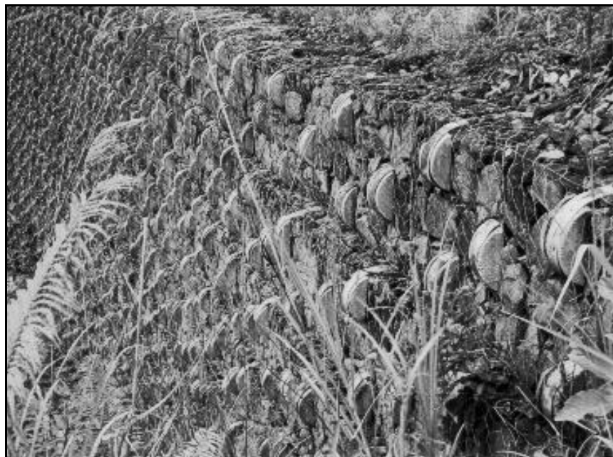
Figura N° 2.2.2: Suelo Reforzado en Malasia (1979)
